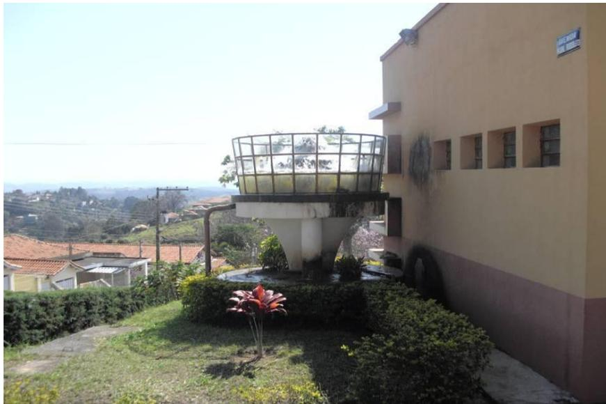
Foto 01 – Chegada de água bruta - Sistema de aeração na ETA Central
