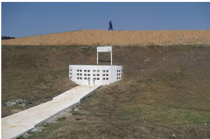
**Foto 17 – Poço de Captação de Líquidos Percolados – Chorume**
