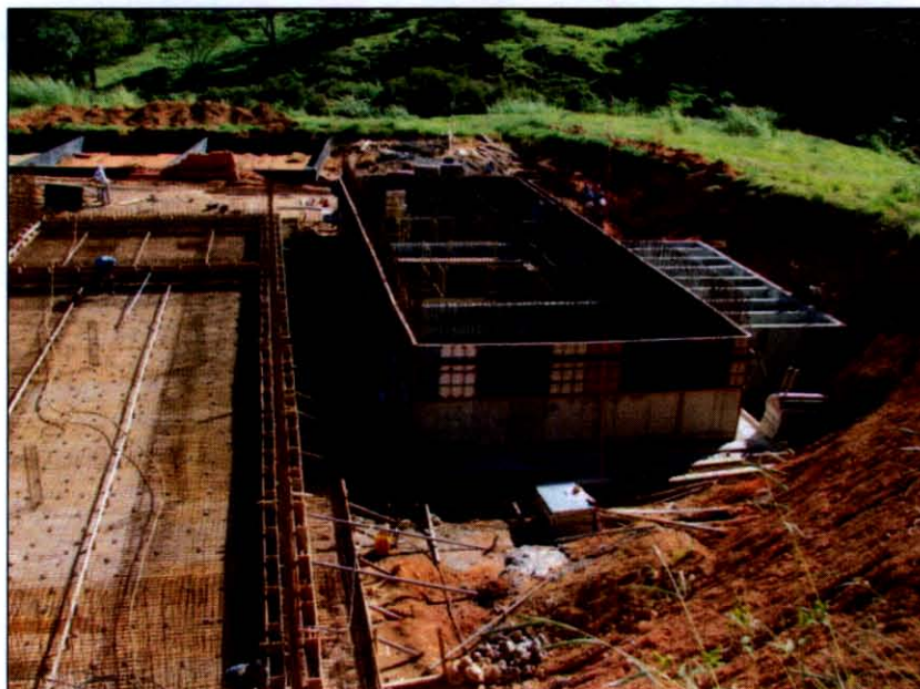
Foto 27 - Tanques já concretados
