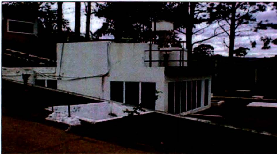
Foto 16 - Reservatório de água bruta para lavagem de filtros - Capestrinho
