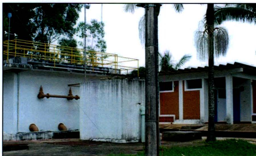
Foto 3 - Vista geral da ETA01 - Sede
