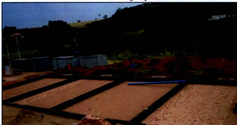
Foto 28 - Leitos de secagem já concluídos
