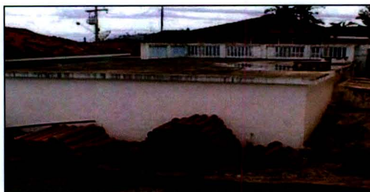
Foto 8 - Reservatório RA03 - Sede
