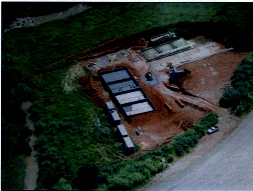
Foto 23 - Vista do início das obras da estação de tratamento de esgoto
