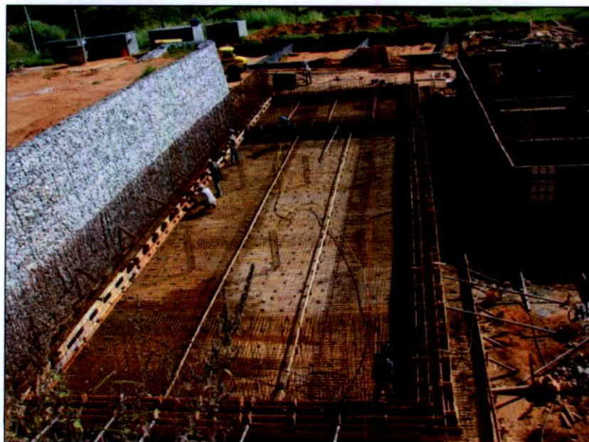
Foto 25 - Vista das obras da ETE - Laje de fundo do RAFA e filtro anaeróbio
