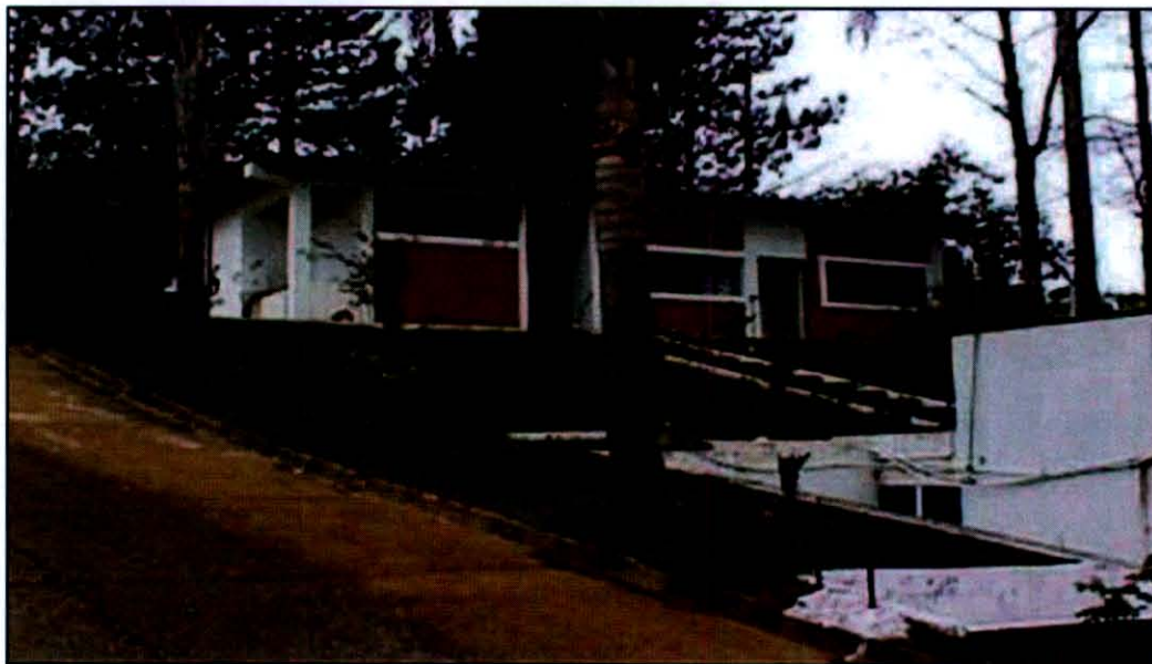
Foto 14 - Vista da casa de química e canal de chegada - Campestrinho
