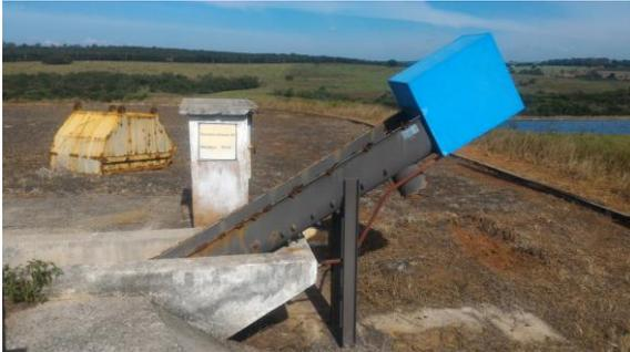
**Foto 3.25 – Parafuso transportador e caixa de areia**
