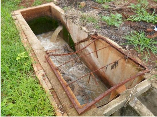
Foto 4.16 - Chegada do esgoto na ETE (grades danificadas)
