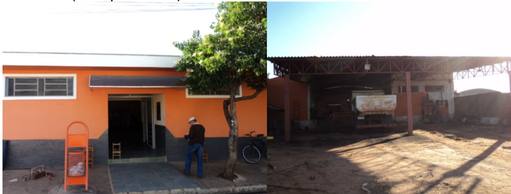
Figura : Almoxarifado do Depto. de Limpeza e Obras
