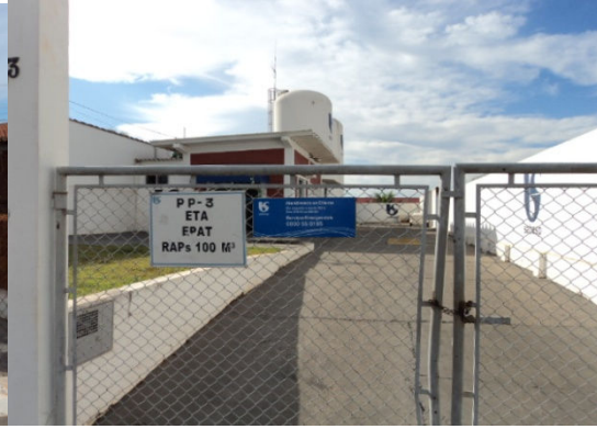
Poço 3 – 14 m 3 l/h vazão
