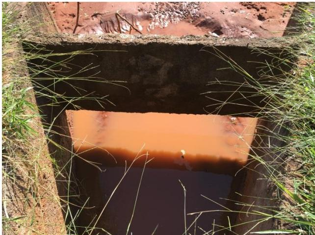
Foto 3.19 – Dissipador parcialmente construído – G.A.P. Rua Idalina M. Fiorese
