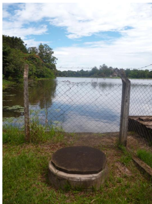
Foto 4.2 - Caixa de Passagem – Água Captada
