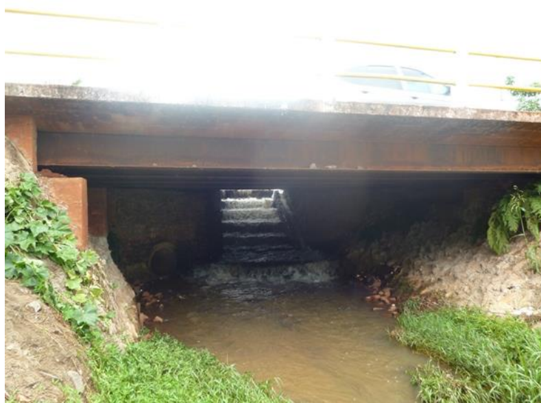
Foto 4.16 - Estrutura sob a Rua Minas Gerais
