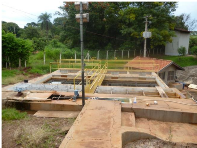
Foto 4.3 - Vista Geral da ETA
