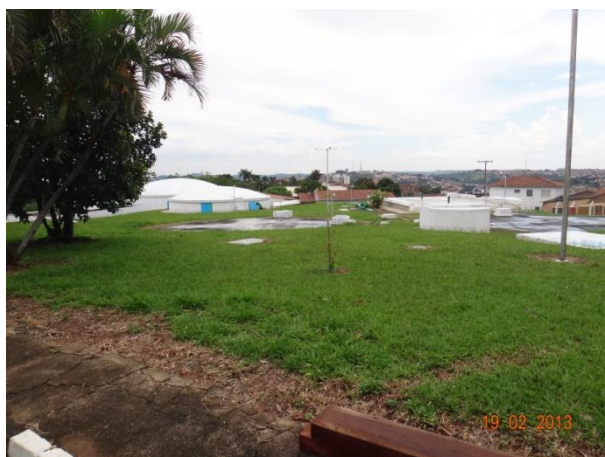
Foto 4.5 – Reservatórios na ETA
