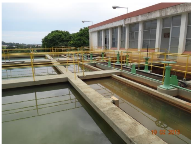
Foto 4.3 – Vista Geral da ETA
