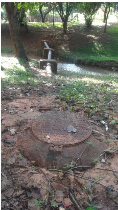
**Foto 3.18 – Poço de Visita da Sabesp e tubulação de esgoto que passa pelo Córrego**
