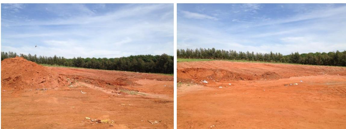
**Figura 7.26** – Ausência de valetas para drenagem de águas pluviais.
