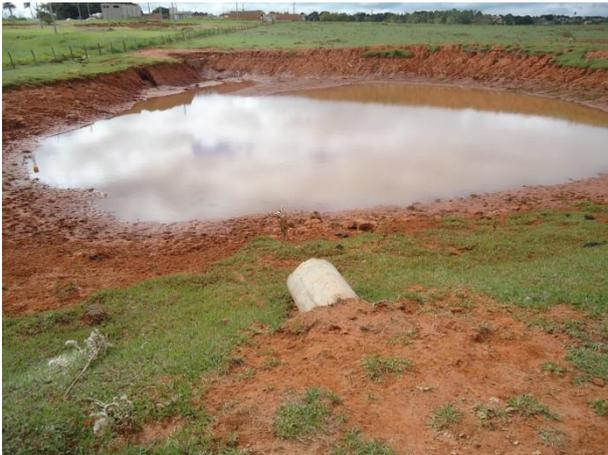
Foto 3.11 – Vertedouro (ladrão) da Bacia de Contenção – Loteamento Nova Estrela
