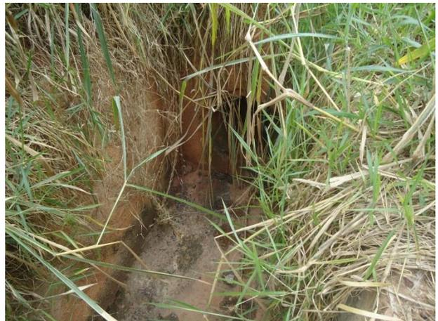
Foto 3.4 – Dissipador antigo da rede de galerias pluviais no CDHU A
