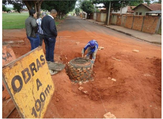
Foto 3.8 – Construção de sistema de drenagem no CDHU B
