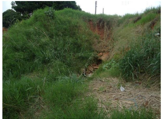
Foto 6.4 – Erosão e saída de rede de Água Pluvial na Rua Coronel Albino
