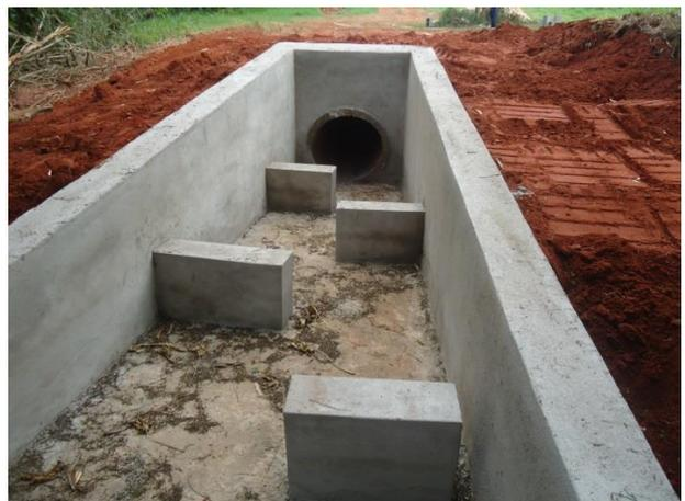
Foto 3.6 - Dissipador novo da rede de galerias pluviais no CDHU B
