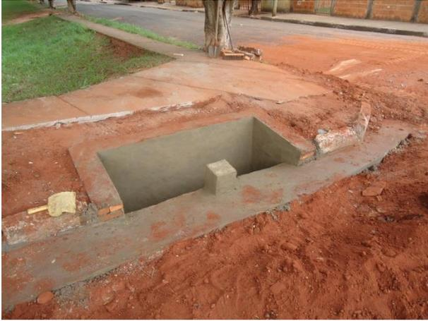
Foto 3.7 – Construção de sistema de drenagem no CDHU B
