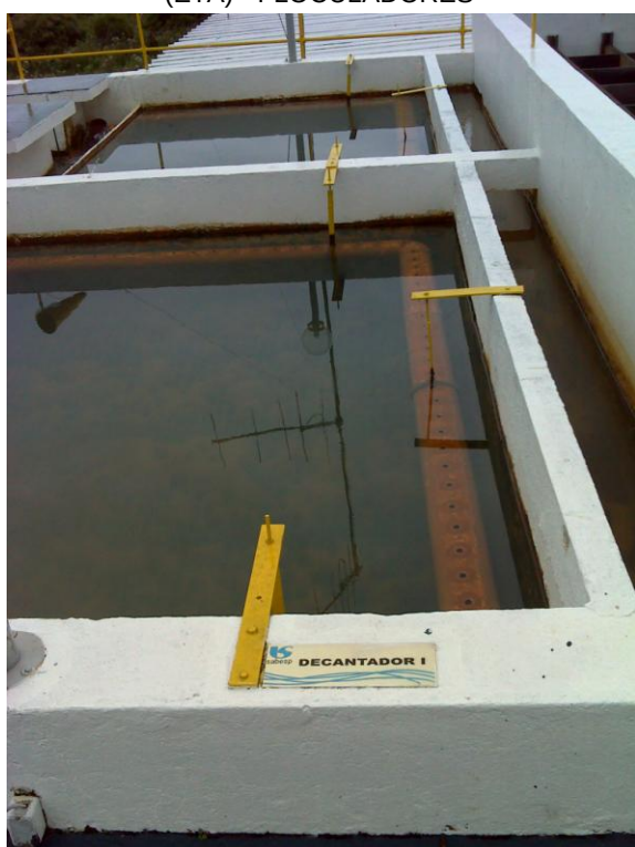
FOTO 4.6 - ESTAÇÃO DE TRATAMENTO DE ÁGUA (ETA) - DECANTADORES
