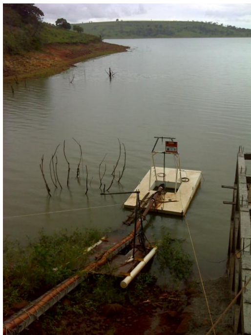
FOTO 4.1 - CAPTAÇÃO NA REPRESA CHAVANTES
