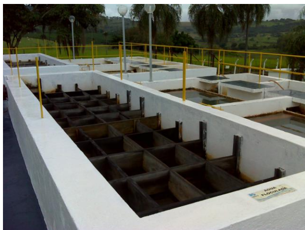
FOTO 4.3 - VISTA DA ESTAÇÃO DE TRATAMENTO DE ÁGUA (ETA) DE FARTURA
