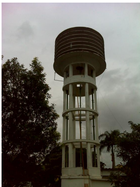
FOTO 4.13 - RESERVATÓRIO R6 - DESATIVADO
