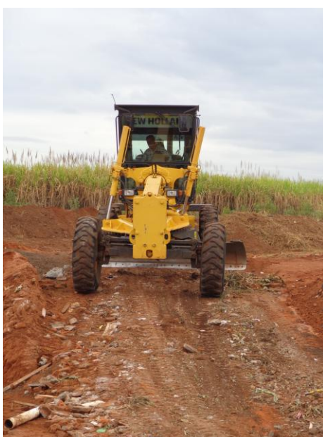
Figura 20. Reutilização dos RCC
