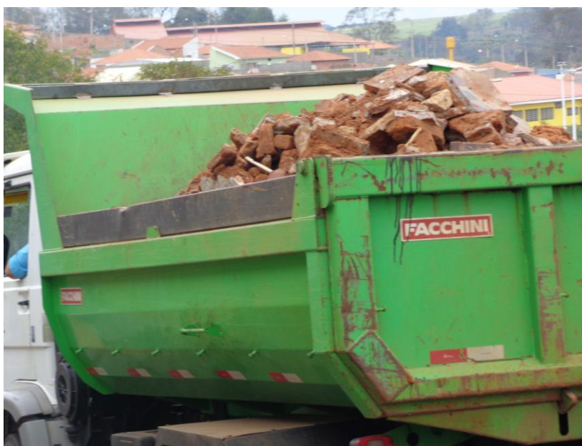
Figura 19. Transporte dos RCC
