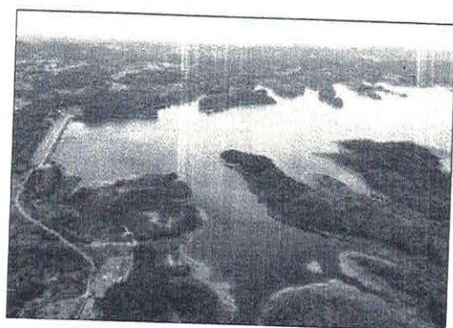
Figura 19 - Represa Ponte Nova Fonte: Sabesp
