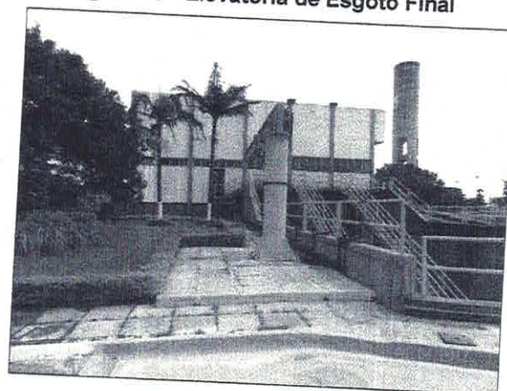
Figura 28 - Elevatória de Esgoto Final
