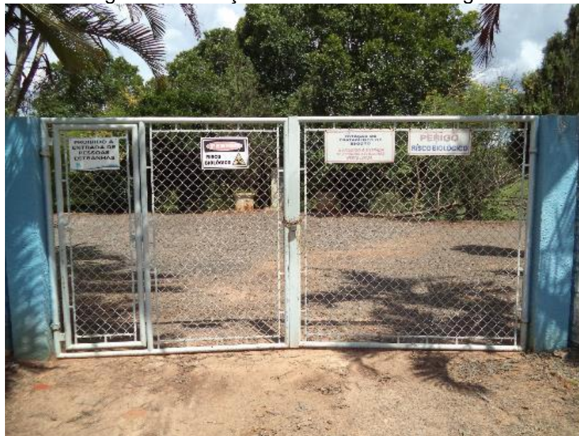
Figura 46. Estação de Tratamento de Esgoto
