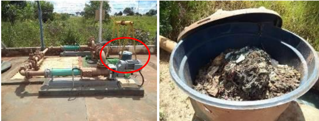
Figura 152. Resíduos provenientes da estação elevatória de esgoto, gradeamento da ETE e caixa de armazenamento temporário dos resíduos
