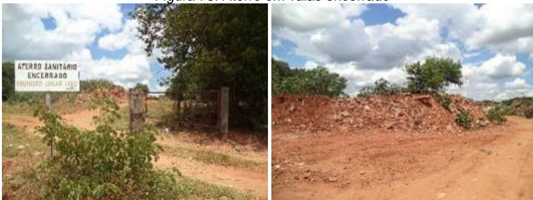
Figura 78. Aterro em valas encerrado
