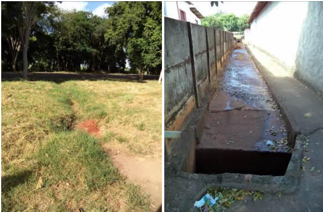
Figura 62. Ponto de lançamento das águas provenientes da Avenida Marginal, com processo erosivo
