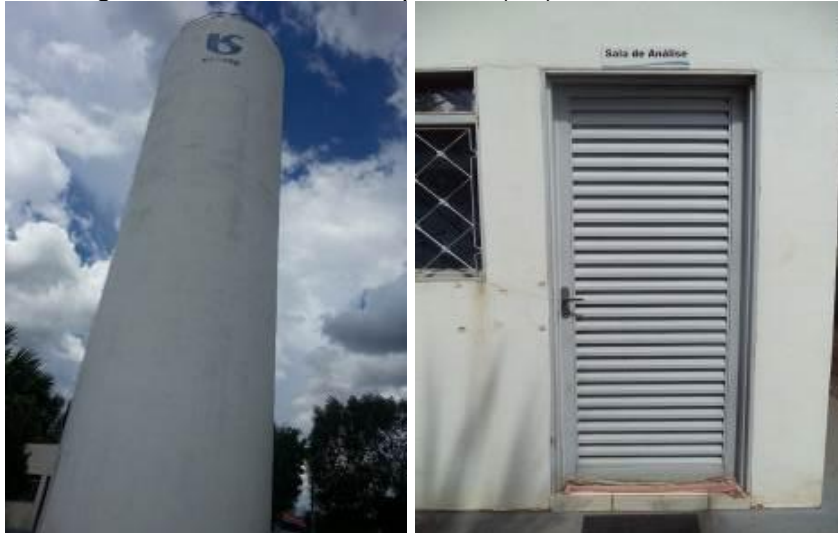
Figura 42. Reservatório apoiado (R2) e sala de análise
