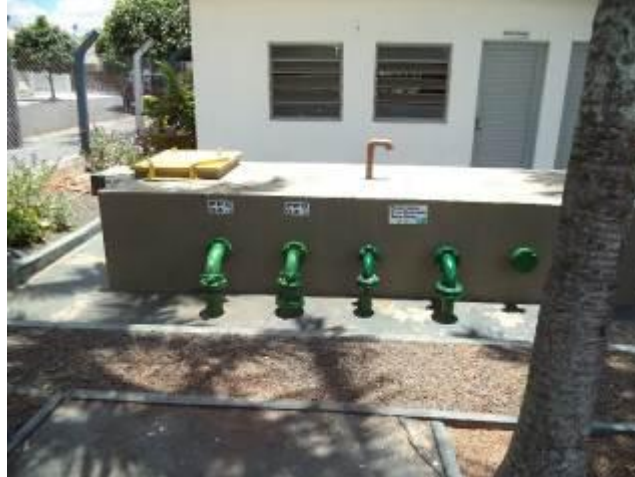
Figura 37. Reservatório semi-enterrado (R1)
