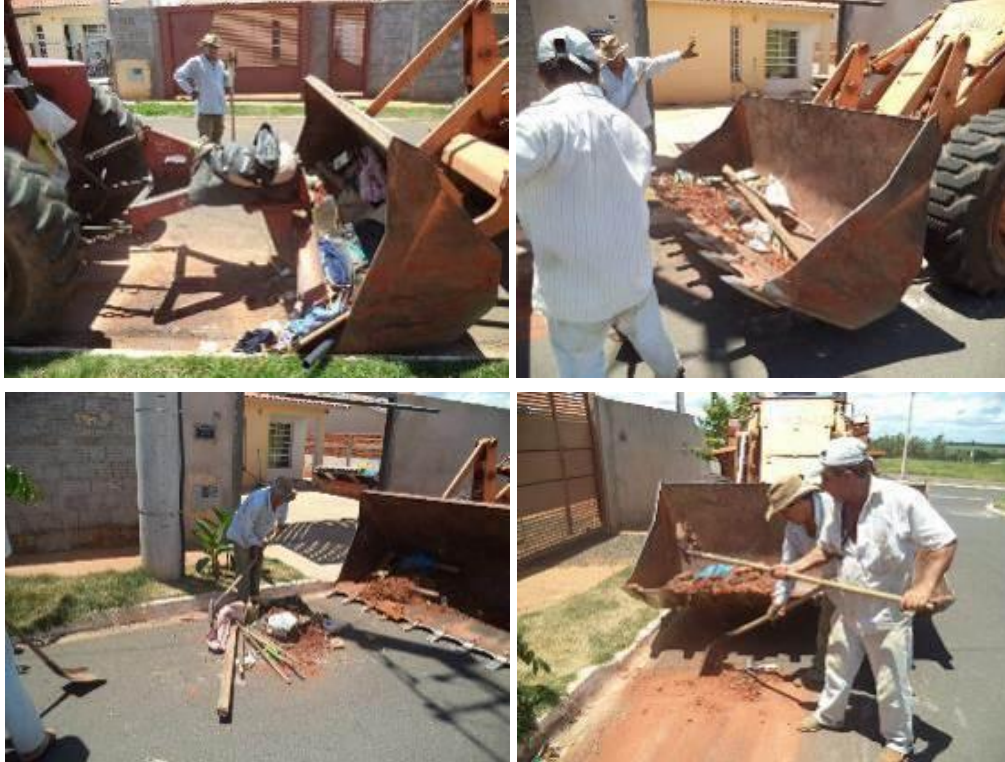
Figura 103. Equipe de coleta dos resíduos da construção civil
