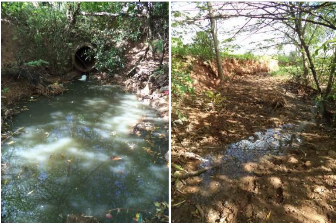
Figura 62. Ponto de lançamento das águas provenientes da Avenida Marginal, com processo erosivo
