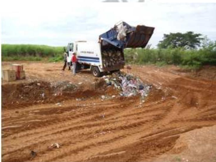
Figura 16 - Descarga dos resíduos no Aterro em Valas.
