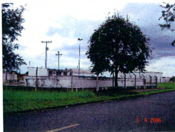
Foto 33 - Centro de reservação Aeroporto - RN8 400 m³
