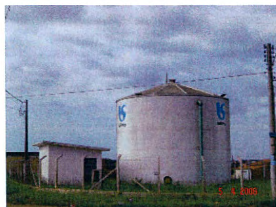
Foto 39 - Centro de reservação Cambuí - R12 - 500 m³
