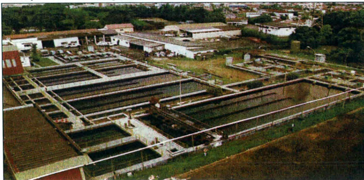
Foto 12 - Vista geral da ETA Redentor
