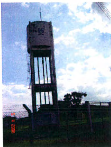
Foto 31 - Centro de reservação Éden - T6 - 30 m³
