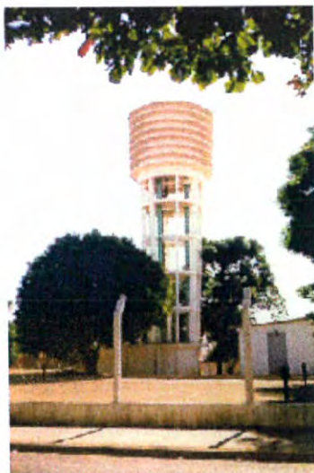
Foto 30 - Centro de reservação Santa Cruz - T5 - 100 m³
