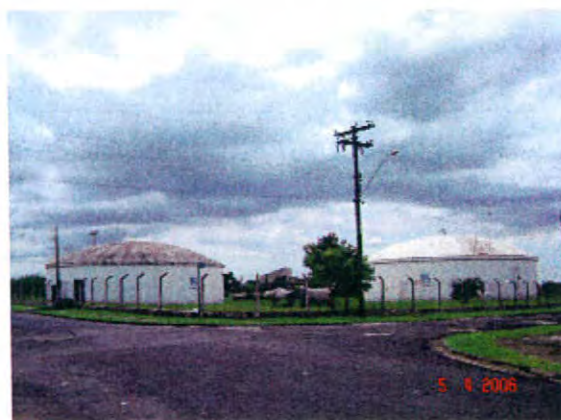
Foto 34 - Centro de reservação Aeroporto - RN8 2 x 1.000 m³
