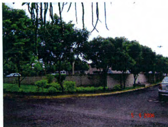
Foto 21 - Centro de reservação na ETA - RN1
