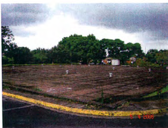
Foto 20 - Centro de reservação na ETA - R1
