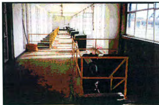
Foto 16 - Sala de comando dos filtros
