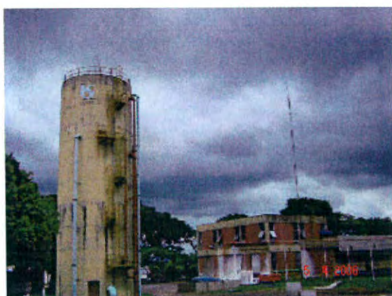
Foto 24 - Centro de reservação na ETA - TN1
