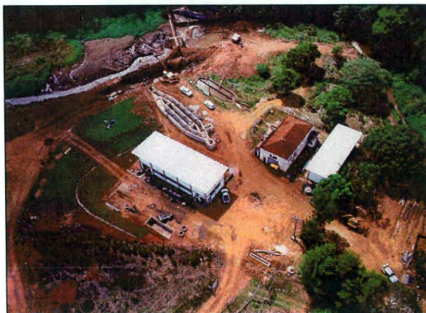
Foto 7 - Obras da nova captação e EE1 - Pouso Alegre
