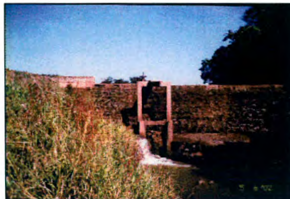
Foto 4 - Barragem de nível Pouso Alegre
