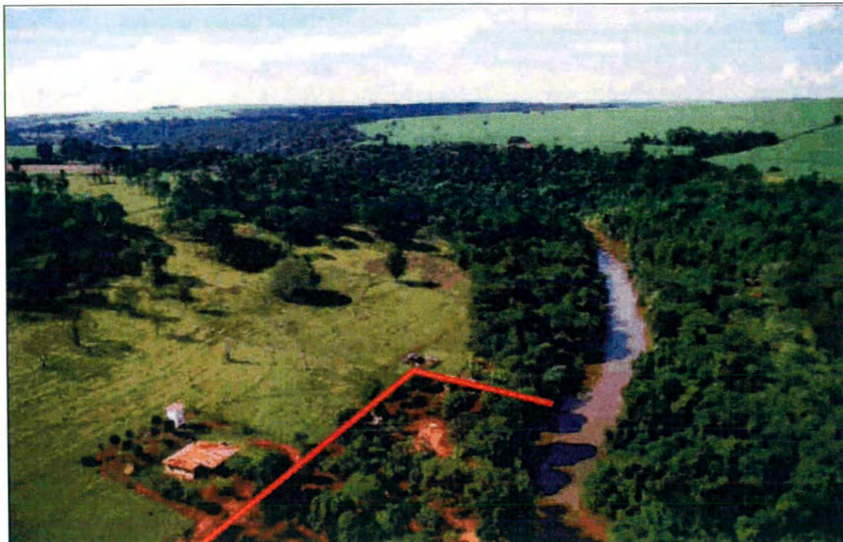
Figura 21 - Vista aérea do local da captação
