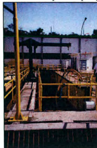
Foto 2 - Vista da caixa de areia na captação do Canoas
