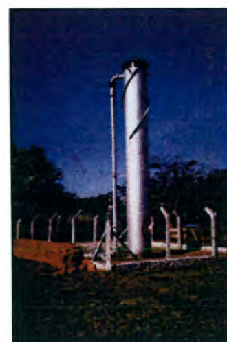
Foto 11 - TAU – Adutora de água bruta - Canoas
