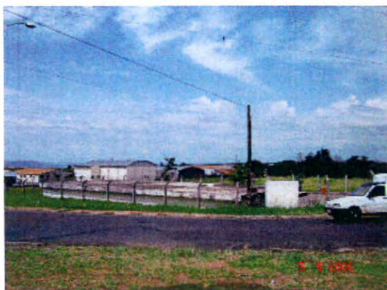
Foto 35 - Reservatório Aeroporto III - 400 m³
