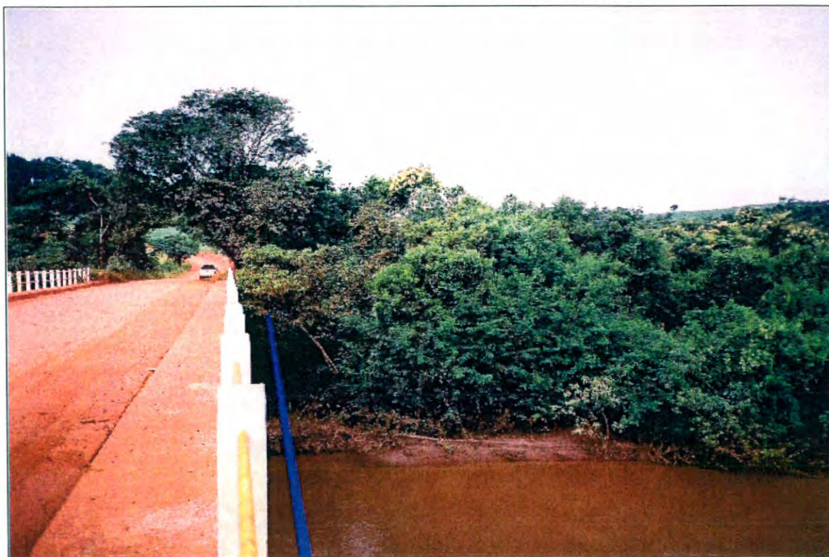
Figura 23 - AAB - Local de travessia do Rio Santa Bárbara
