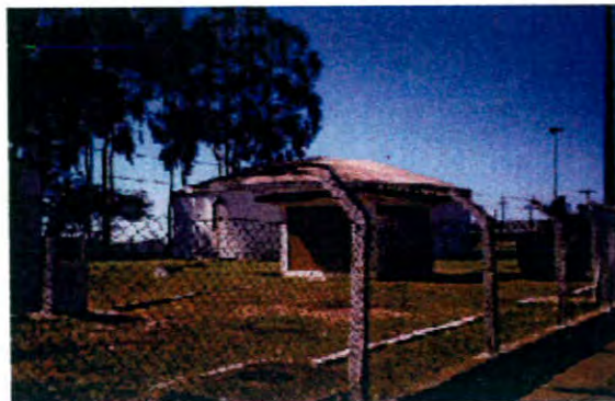
Foto 32 - Centro de reservação Vicente Leporace R7/RN7 - 1800/1500m³
