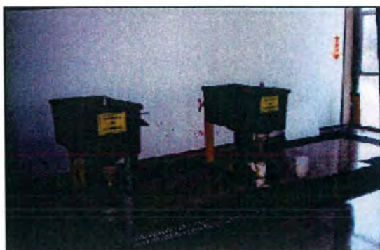
Foto 18 - Dosadores de sulfato de alumínio (uso eventual)
