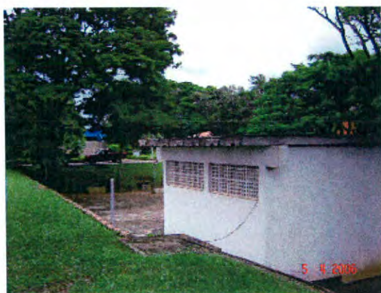
Foto 19 - Centro de reservação na ETA - R0
