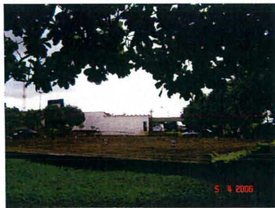
Foto 22 - Centro de reservação na ETA - R2
