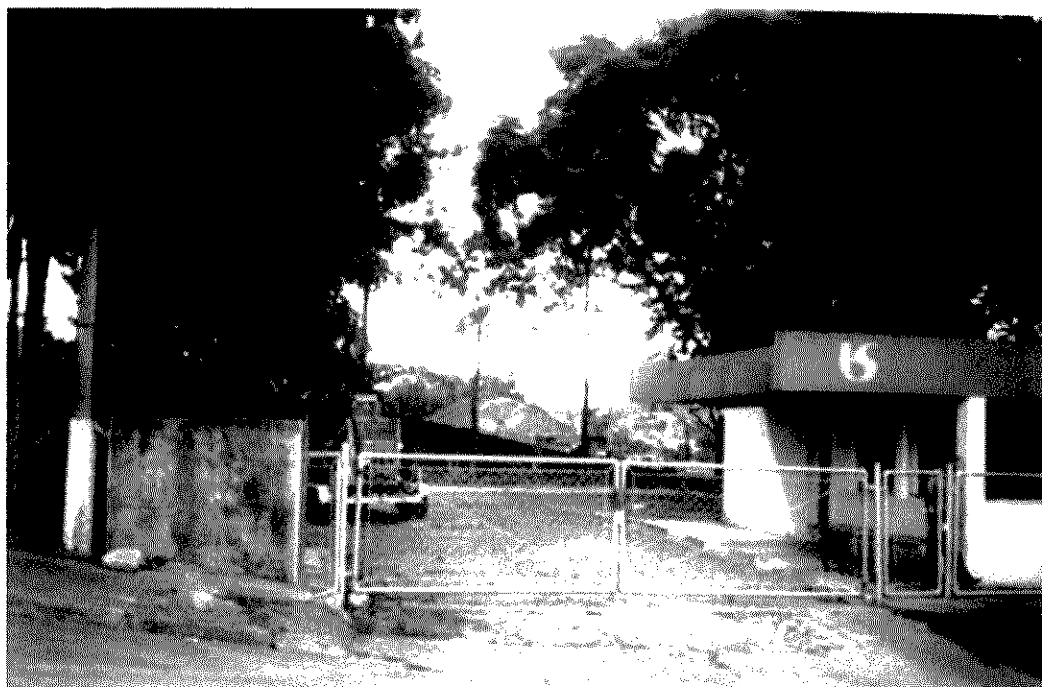
Entrada ao Centro de Reservação Francisco Morato – Rua Jandira, s/ nº Centro
