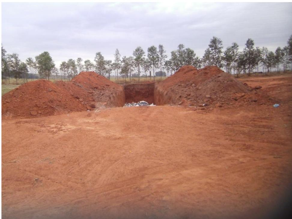
**Figura 18** - Vala escavada no Aterro sendo preenchida com Resíduos
