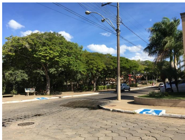
Foto 3.20 – Vista Geral da Área Alagada
