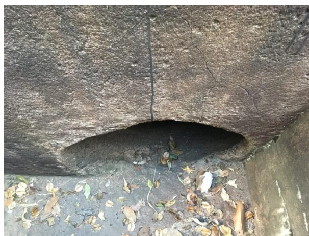
Foto 3.14 – Saída da GAP existente
