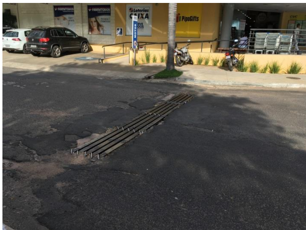
Foto 3.11 – Grelha existente na área de alagamento
