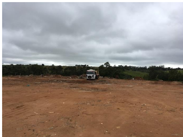
Foto 3.6 - Vista Geral Aterro de RCC
