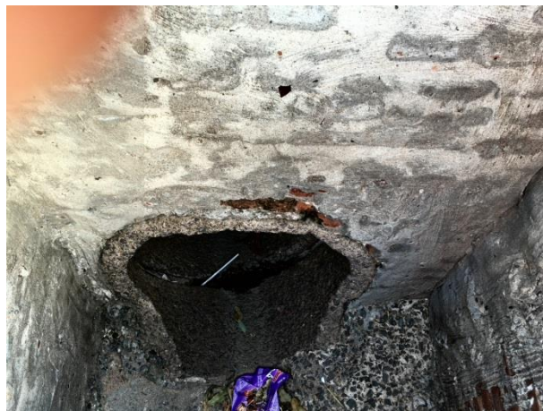
Foto 3.18 – Saída da GAP existente
