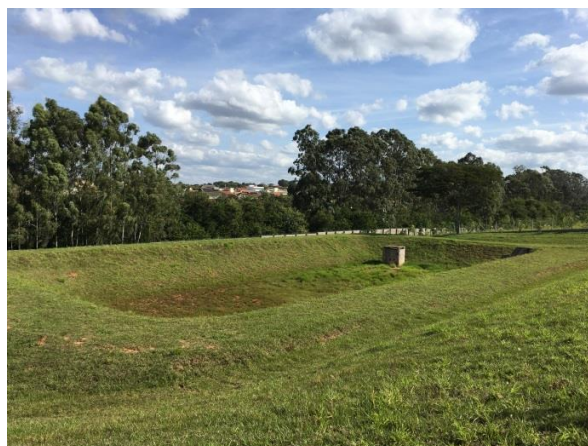
Foto 3.32 – Bacia de Contenção Gran Villaggi
