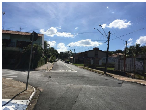
Foto 3.24 – Vista Geral da Área Alagada
