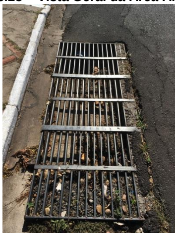
Foto 3.25 – Grelha existente na área de alagamento
