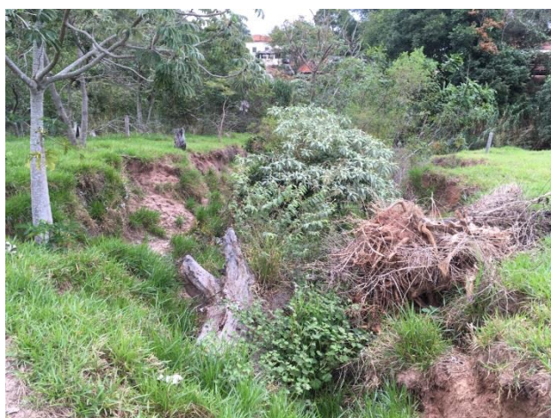
Foto 3.36 – Erosão próxima as plantações
