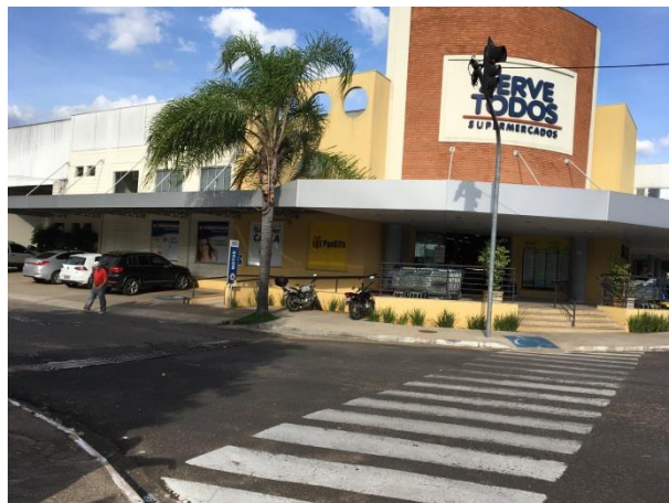
Foto 3.12 – Vista Geral da Área Alagada
