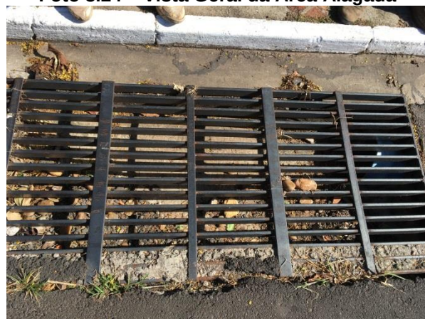
Foto 3.26 – Grelha existente na área de alagamento
