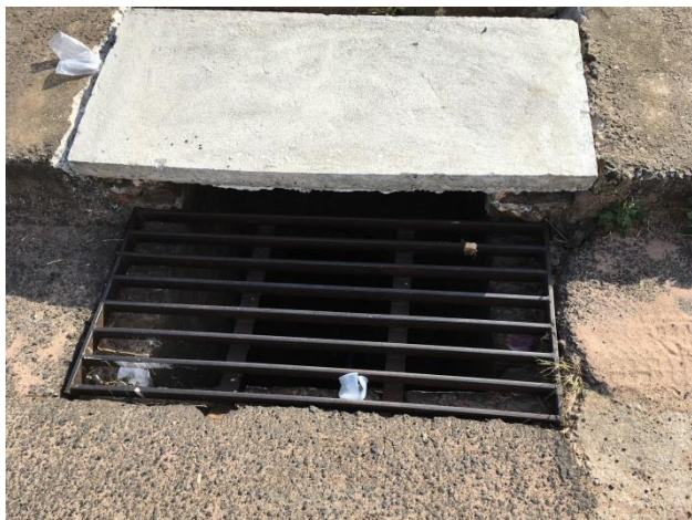
Foto 3.17 – Grelha existente na área de alagamento
