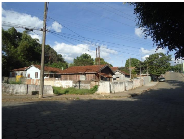
Foto 3.29 – Vista Geral da Área Alagada
