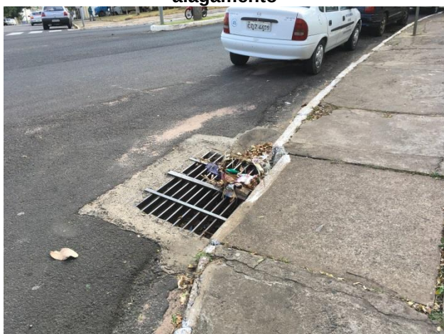
Foto 3.13 – Grelha existente na área de alagamento
