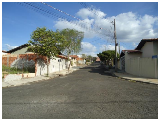
Foto 3.28 – Vista Geral da Área Alagada
