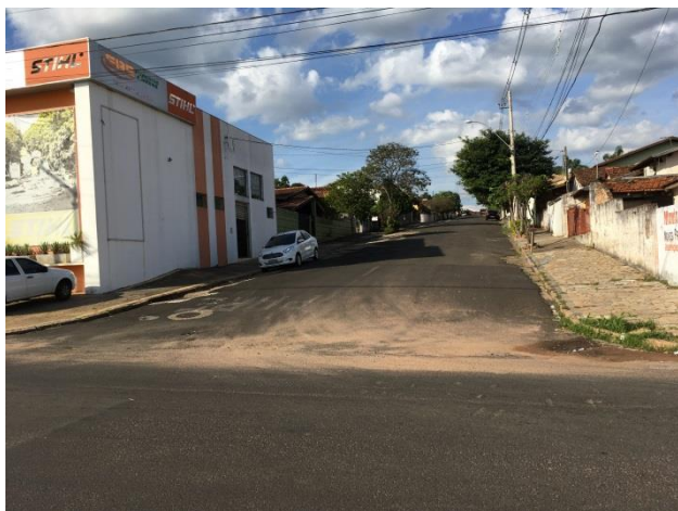
Foto 3.15 – Vista Geral da Área Alagada
