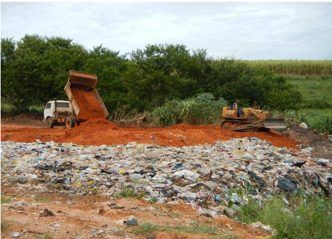
Foto 11: Frente de disposição final de rejeitos da Central de Tratamento e Disposição Final de Resíduos Sólidos Urbanos, localizada à sudoeste da área de aterramento de rejeitos.
