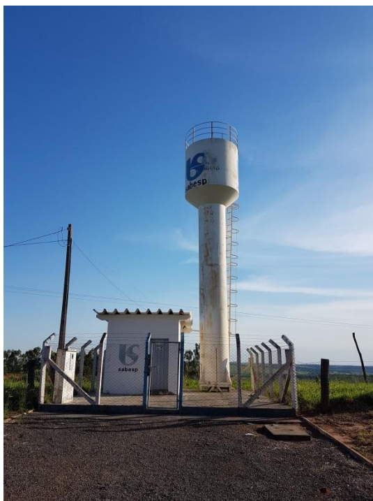
Foto 3.14 – Reservatório Elevado do Distrito de Prudêncio e Moraes
