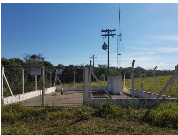
Foto 3.5 - Identificação do Poço: Poço-19
