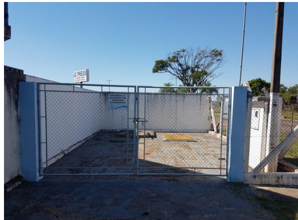
Foto 3.6 - Identificação do Poço: Poço-20
