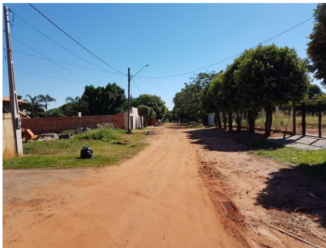
Foto 3.33 – Área de alagamento Rua B
