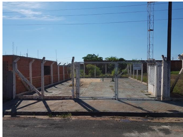
Foto 3.4 - Identificação do Poço: Poço-17
