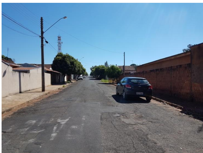
Foto 3.27 – Área de alagamento Av. Plínio R do Val x Rua Jucelino P Oliveira
