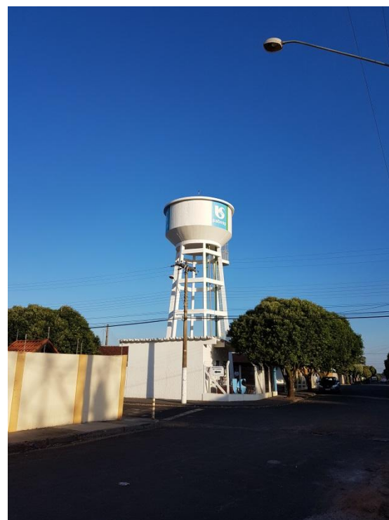
Foto 3.13 – Reservatório Elevado do Distrito Sede
