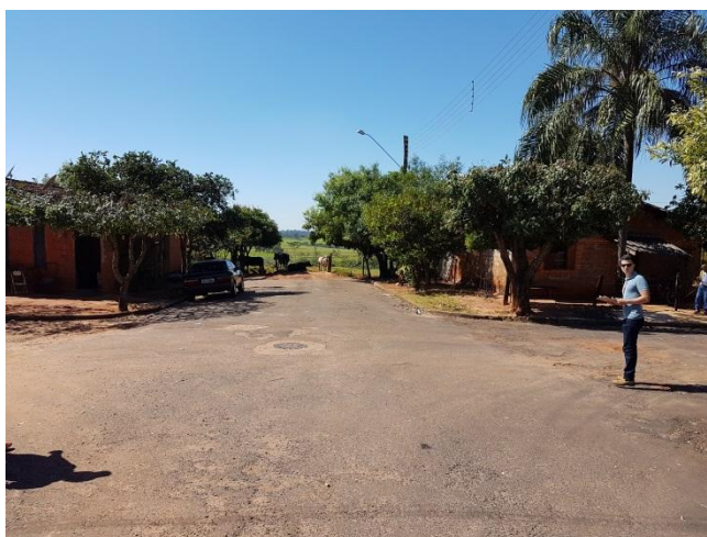
Foto 3.37 – Erosão em área particular localizada no final da rua Doutor Buno Martins
