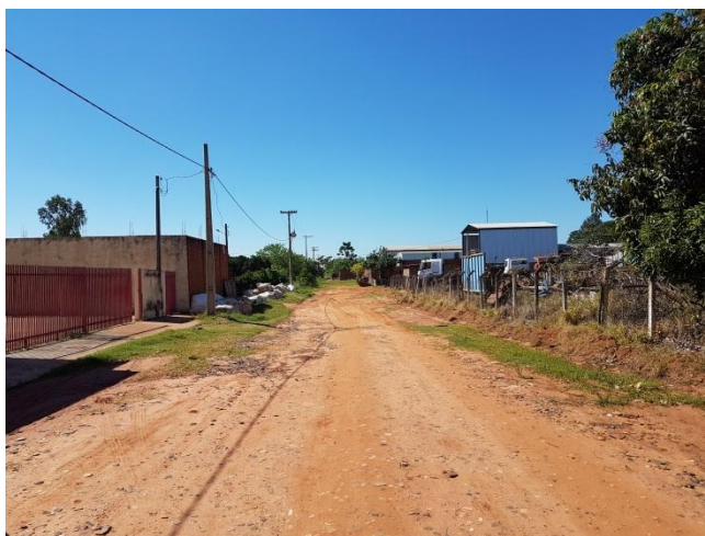
Foto 3.34 – Área de alagamento Rua Antônio Zocal
