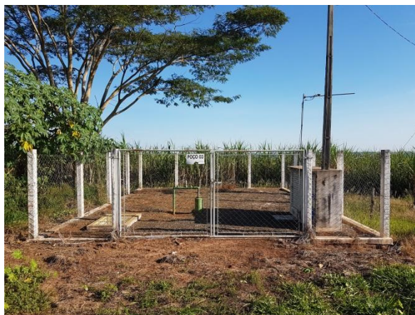
Foto 3.8 - Identificação do Poço: Poço-03 – Distrito de Prudêncio e Moraes
