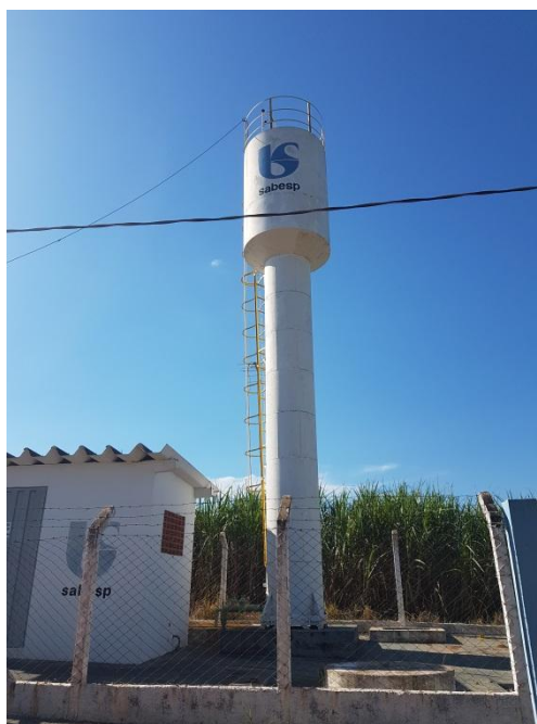
Foto 3.16 – Reservatório Elevado do Povoado de São Luiz do Japiuba
