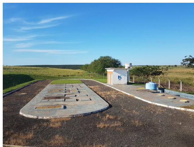
Foto 3.20 – Vista geral – Reatores
