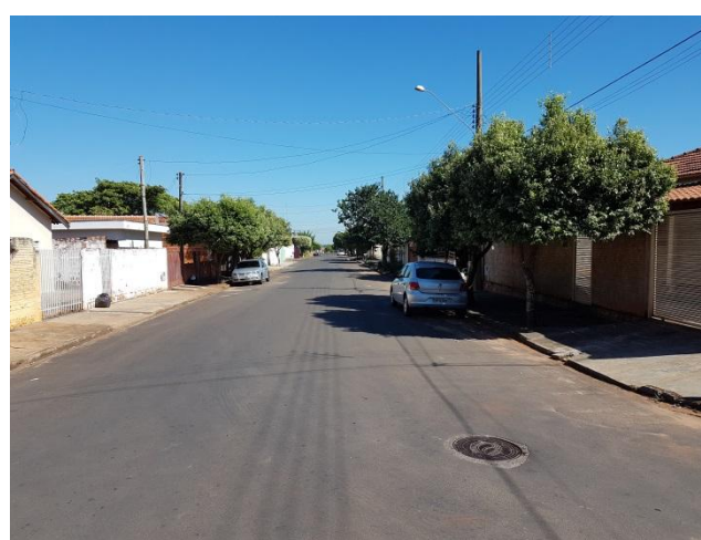
Foto 3.28 – Área de alagamento Av. Plínio R do Val x Rua Jucelino P Oliveira
