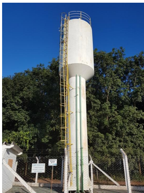
Foto 3.15 – Reservatório Elevado do Povoado de Nova Palmira
