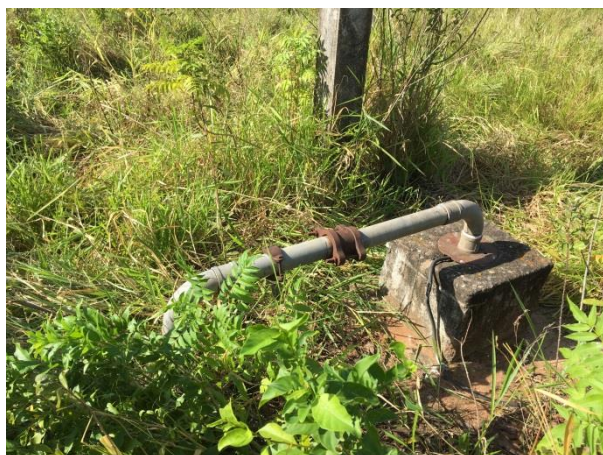
Foto 3.1 - Identificação do Poço: P01
