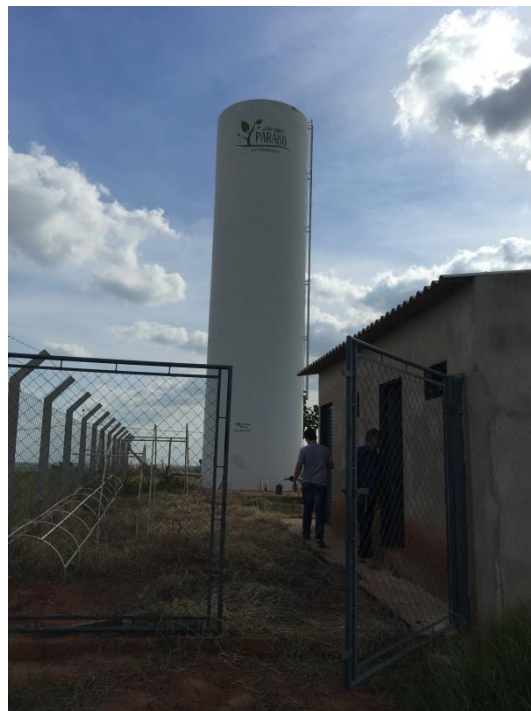
Foto 3.21 - Identificação do Reservatório: RAP-06
