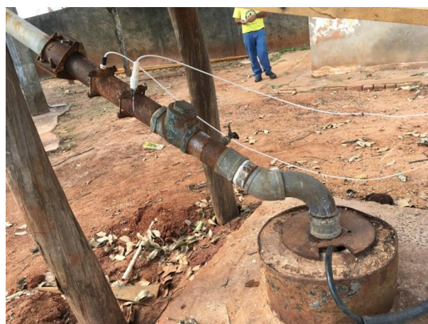
Foto 3.4 - Identificação do Poço: P04
