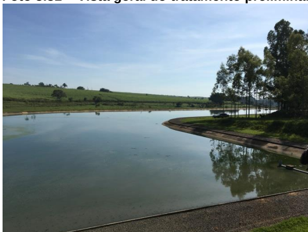
Foto 3.33 – Vista da lagoa facultativa
