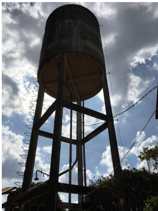
Foto 3.18 - Identificação do Reservatório: REL-03
