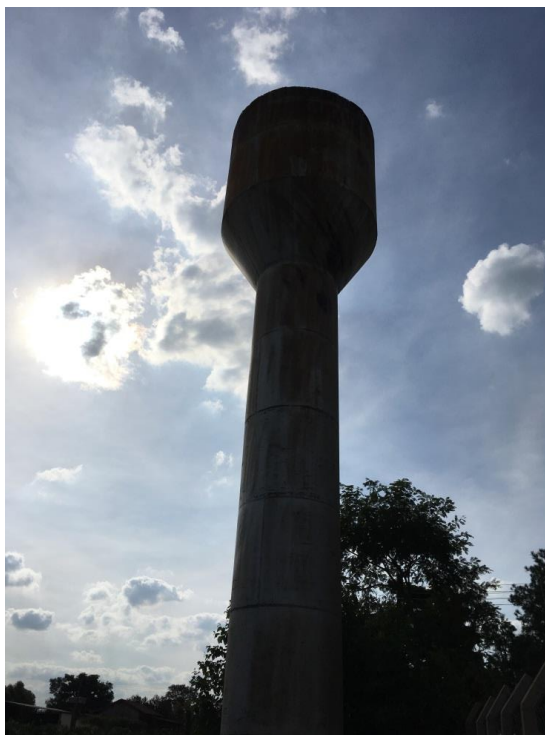
Foto 3.24 - Identificação do Reservatório desativado
