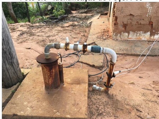
Foto 3.8 - Identificação do Poço: P08
