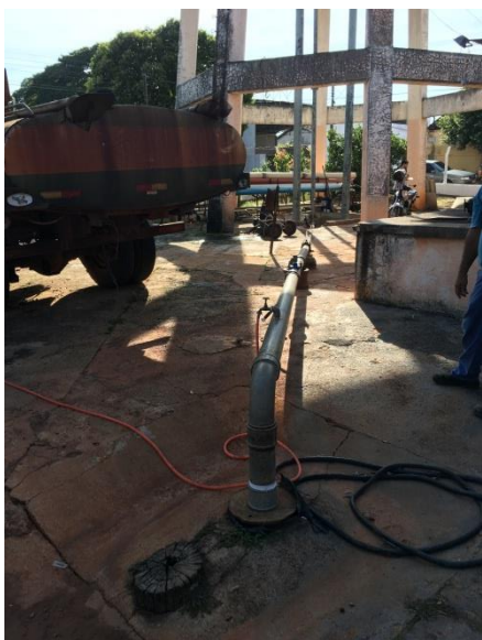
Foto 3.3 - Identificação do Poço: P03
