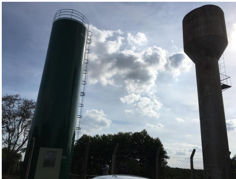
Foto 6.1 – Vista dos reservatórios do Distrito de Macucos: à esquerda reservatório atual em funcionamento e à direita reservatório desativado
