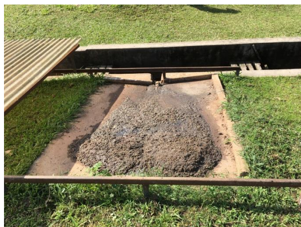
Foto 3.30 – Leito de secagem da areia removida no desarenador
