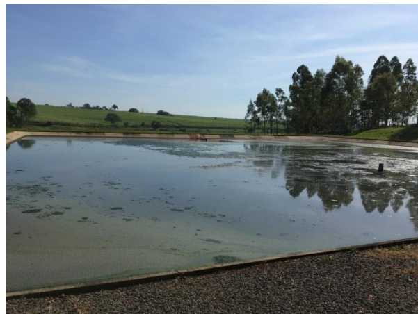
Foto 3.32 - Vista geral da lagoa anaeróbia
