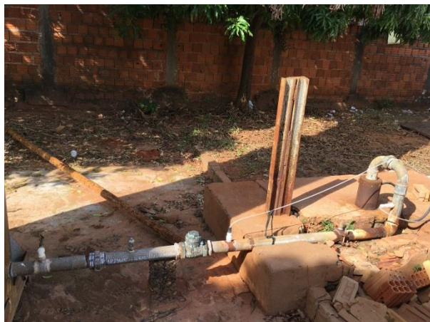
Foto 3.5 - Identificação do Poço: P05
