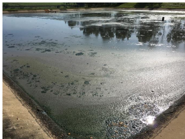
Foto 6.3 – Vista da presença de sobrenadante nos cantos da lagoa anaeróbia
