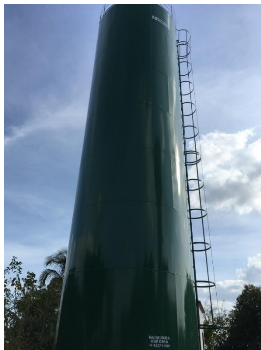
Foto 3.23 - Identificação do Reservatório: RAP-08
