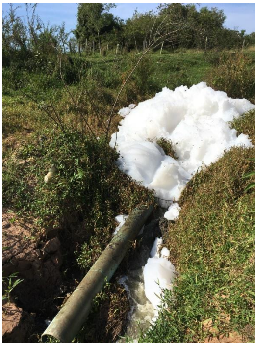
Foto 6.6 – Emissário danificado e formação de espuma no lançamento final
