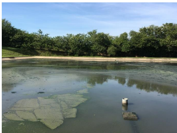
Foto 6.2 – Vista geral da presença de placas de lodo desprendido do fundo da lagoa anaeróbia
