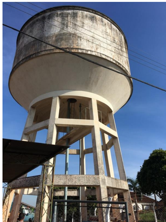
Foto 3.17 - Identificação do Reservatório: REL-02
