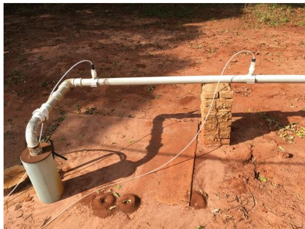
Foto 3.6 - Identificação do Poço: P06
