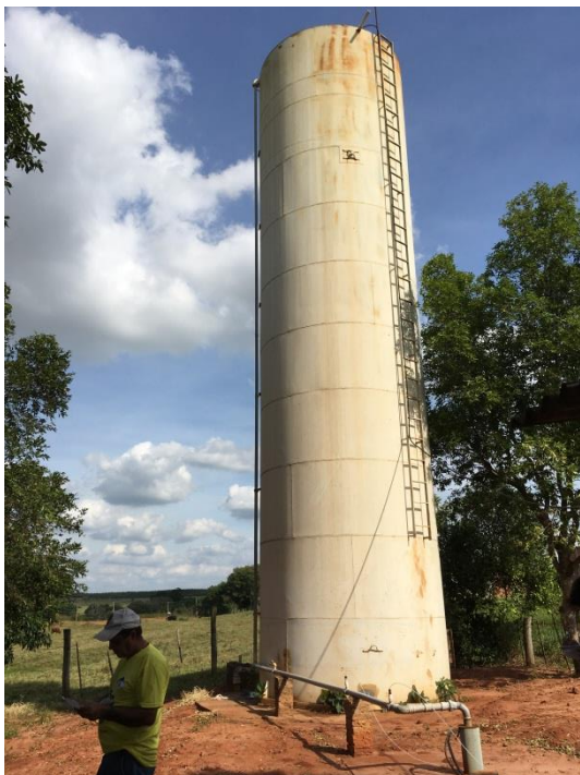
Foto 3.20 - Identificação do Reservatório: RAP-05
