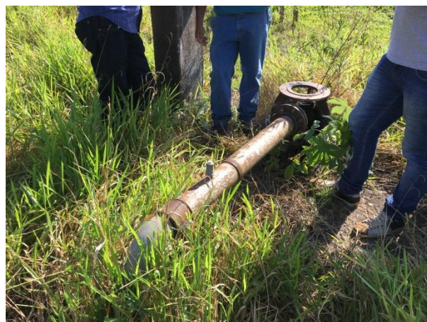
Foto 3.2 - Identificação do Poço: P02
