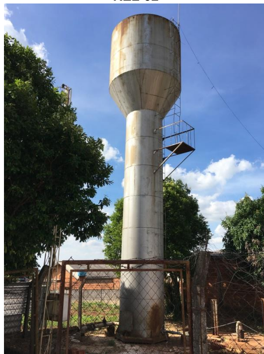
Foto 3.19 - Identificação do Reservatório: REL-04
