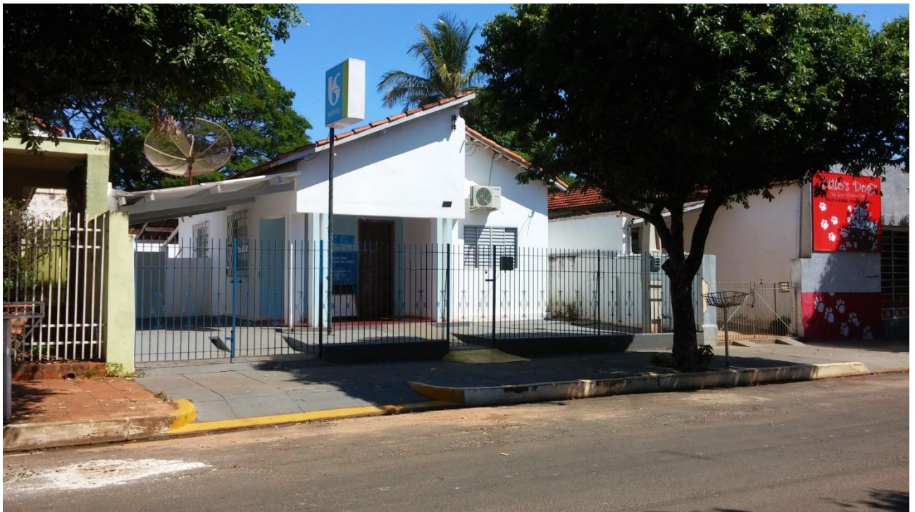
Figura 26 - Instalações da SABESP
