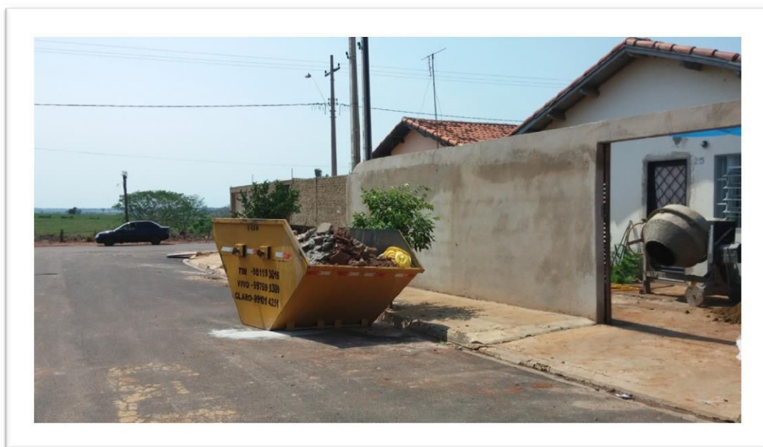
Figura 19 - Caçamba Estacionária para a coleta da Construção e Demolição
