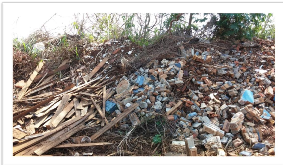
Figura 18 - Depósito de Resíduos da Construção e Demolição
