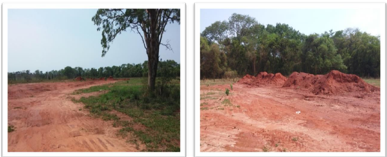
Figura 9 – Aterro em Vala
