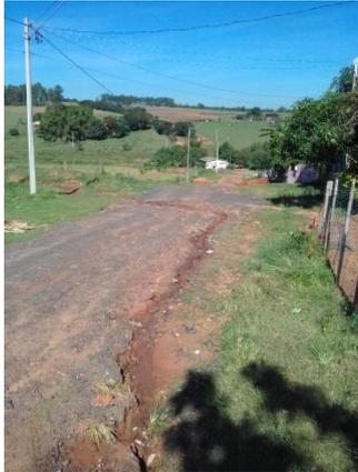
Foto 3.31 – Erosão causada pela dissipação da água de chuva – Rua Duque de Caxias
