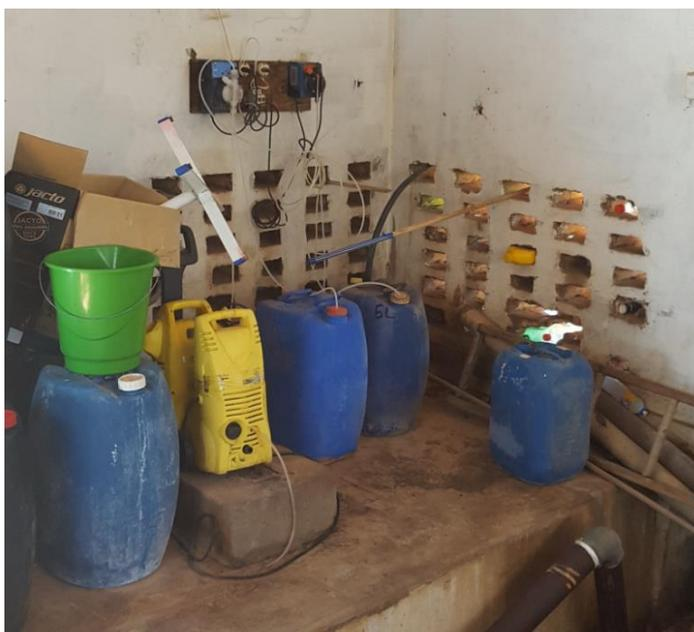
Foto 3.8 – Unidades de Fluoretação e Cloração com bomba dosadora
