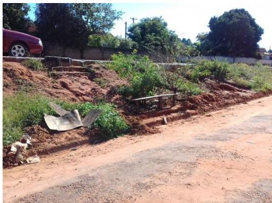
Foto 3.27 – Erosão causada pela dissipação da água de chuva – Rua José Jirschik
