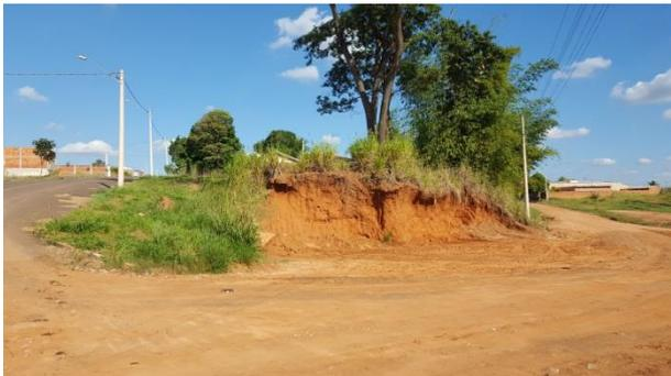
Foto 3.23 – Erosão causada pela dissipação da água de chuva – Rua João Hunziker
