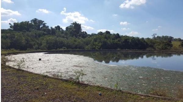
**Foto 6.1 – Vista geral da presença de placas de lodo desprendido do fundo da lagoa anaeróbia**
