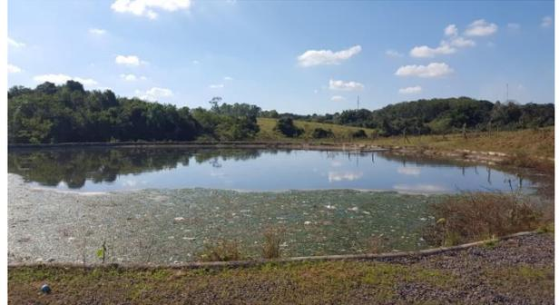
**Foto 6.2 – Vista da presença de sobrenadante nos cantos da lagoa anaeróbia**
