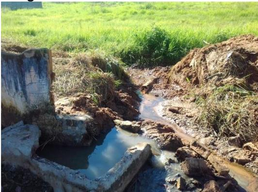
Foto 3.25 – Erosão causada pela dissipação da água de chuva – Avenida Marginal
