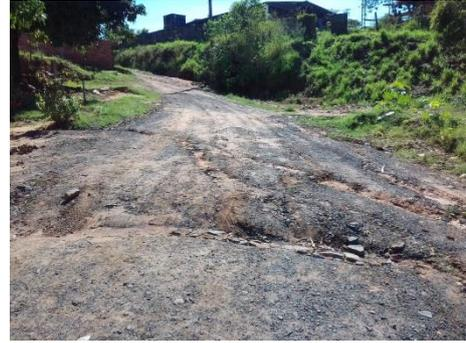
Foto 3.30 – Erosão causada pela dissipação da água de chuva - Rua Duque de Caxias
