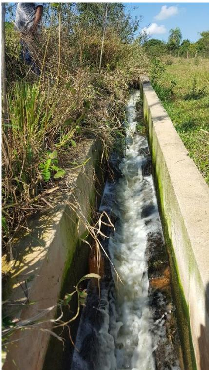
Foto 3.20 – Saída do Efluente – Escada de Aeração
