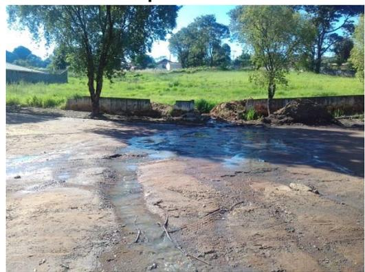
Foto 3.26 – Carreamento de materiais ocasionado pelo escoamento superficial – Avenida Marginal
