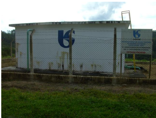
FOTO 4.9 – RESERVATÓRIO DO BAIRRO CAPINZAL
