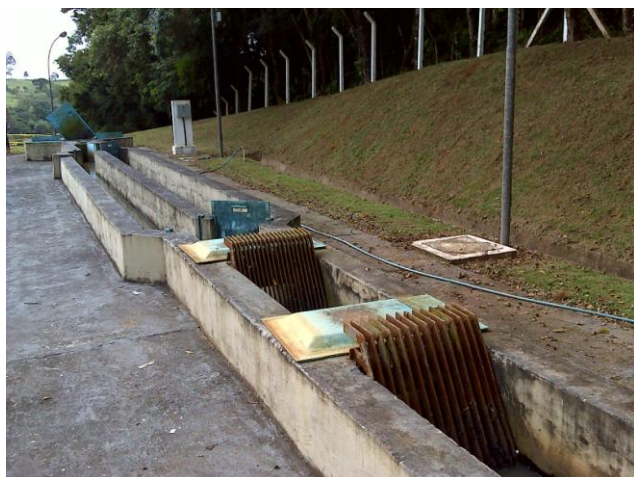
FOTO 4.20 – ETE SEDE - GUAPIARA
