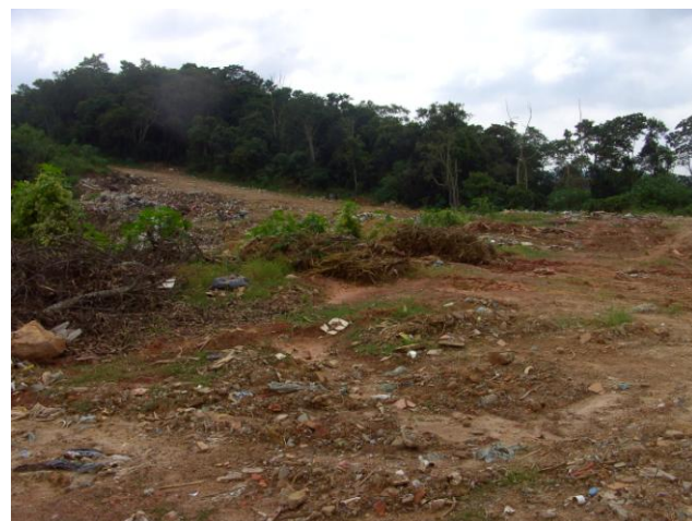
FOTO 4.25 - ATERRO SANITÁRIO - VALAS
