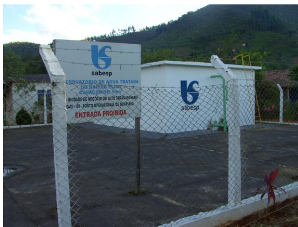
FOTO 4.11 – RESERVATÓRIO DO BAIRRO DOS ELIAS
