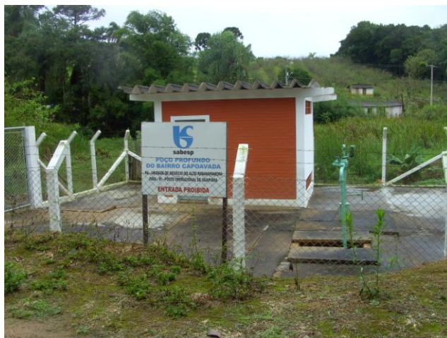
FOTO 4.17 – POÇO PROFUNDO BAIRRO CAPOAVADA
