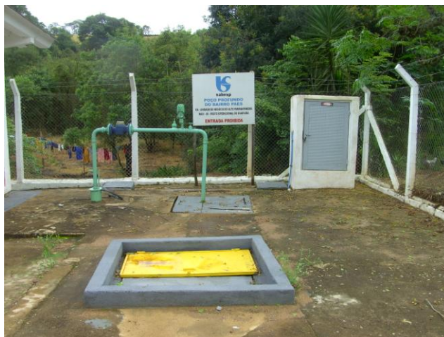
FOTO 4.14 – POÇO PROFUNDO BAIRRO DOS PAES/MOTAS
