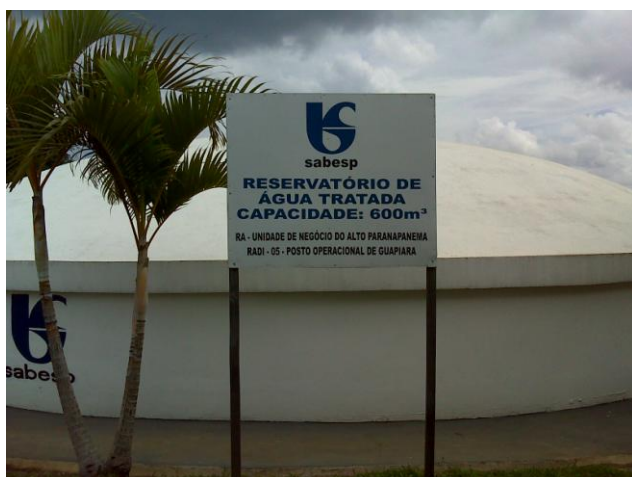
FOTO 4.5 - RESERVATÓRIO SEDE - GUAPIARA
