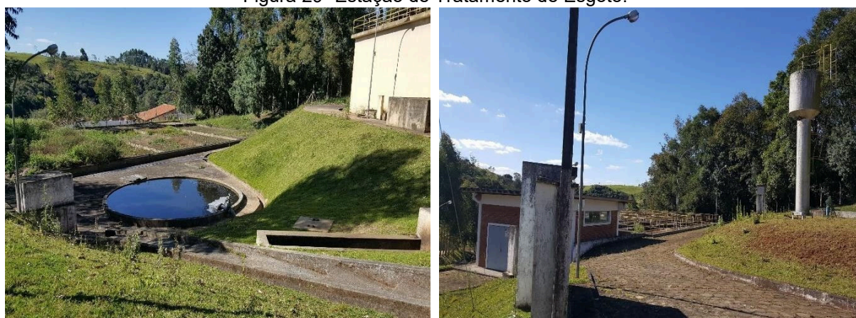
Figura 29- Estação de Tratamento de Esgoto.
