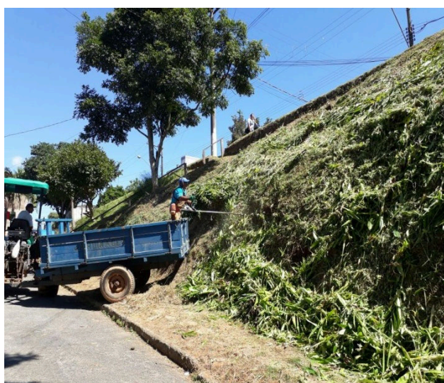
Figura 25 – Roçada e Varrição no Município de Guapiara
