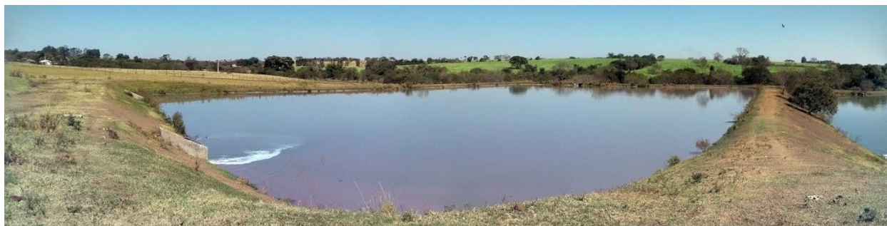
Foto 3.77 – Vista da segunda lagoa facultativa da ETE Barra Grande
