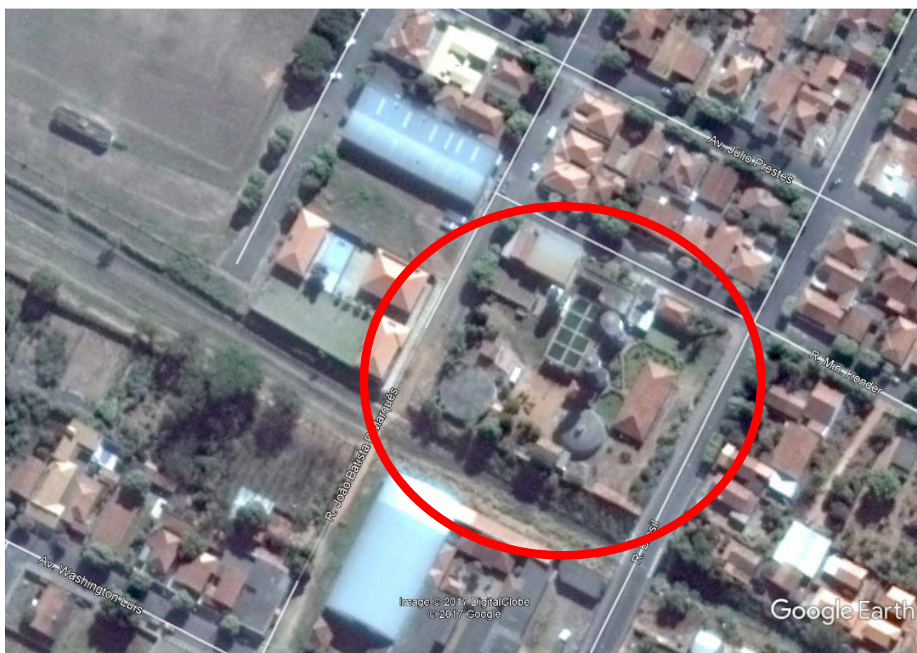
Foto 3.15 – Vista aérea da Estação de Tratamento de Água de Guararapes
