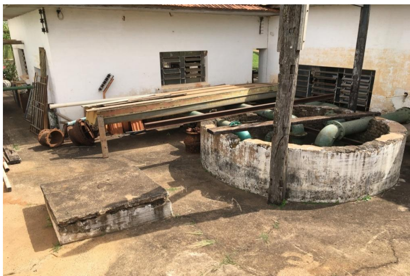
Foto 3.9 – Vista do poço de sucção da captação da EEAB
