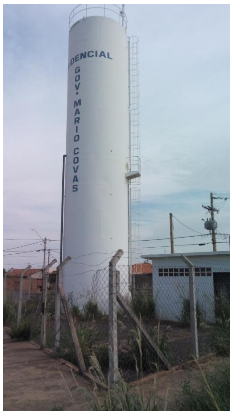
Foto 3.36 - Reservatório Residencial Mário Covas
