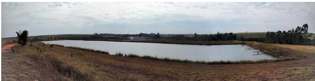
Foto 3.63 – Vista da primeira Lagoa Facultativa da ETE Frutal
