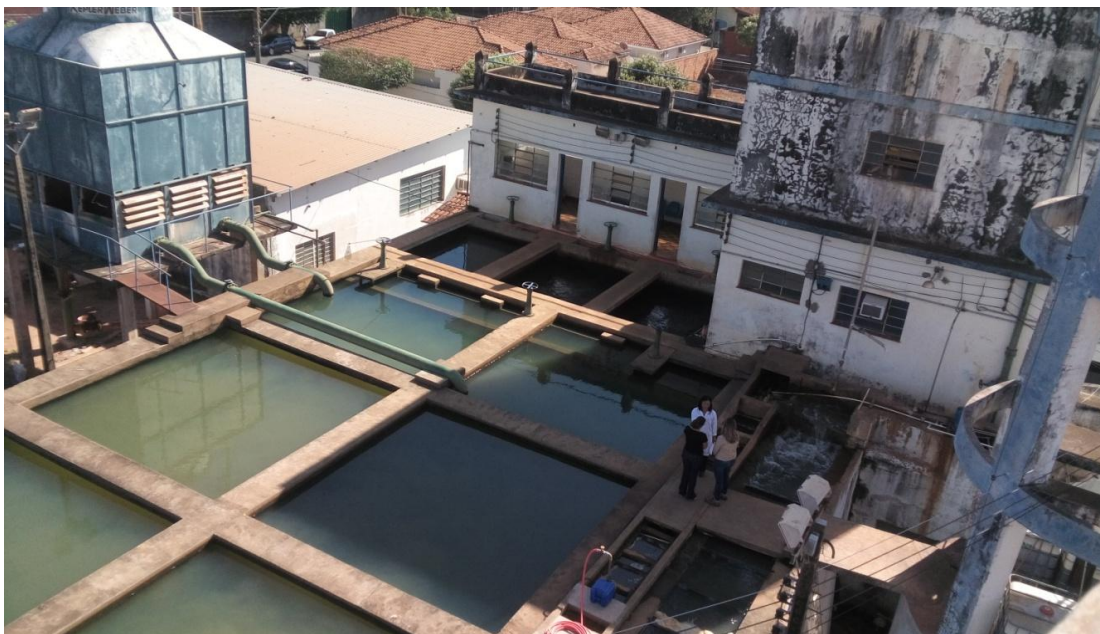
Foto 3.20 – Vista dos decantadores e dos filtros a partir do reservatório elevado
