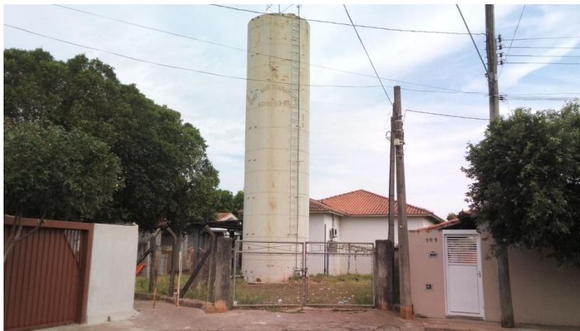
Foto 3.41- Reservatório COHAB 3 - Inativo
