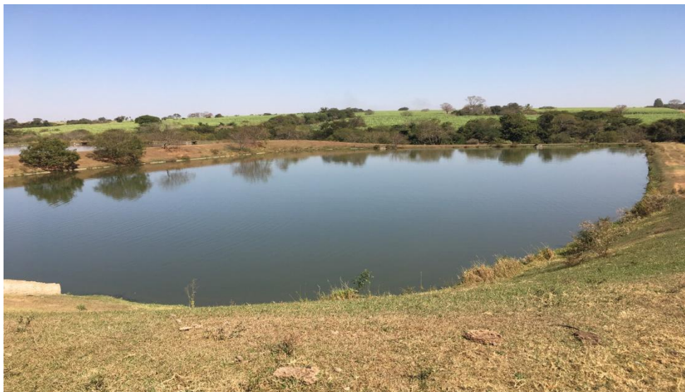
Foto 3.73 – Vista da primeira lagoa facultativa – ETE Barra Grande
