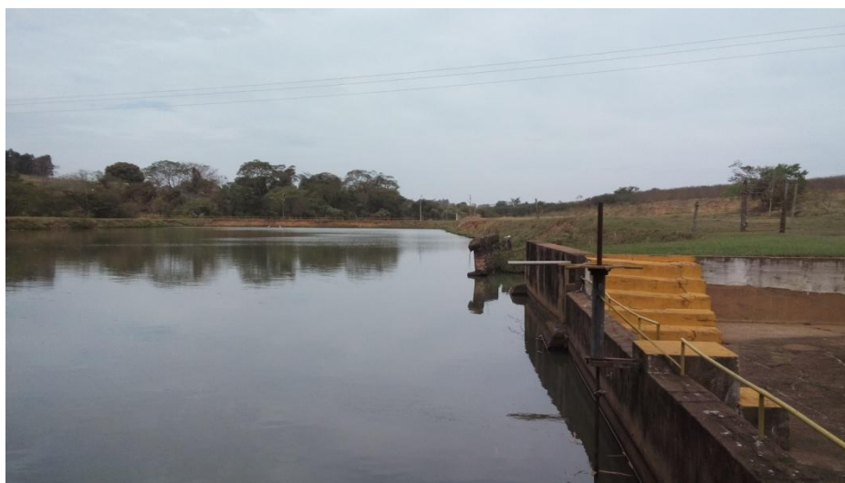
Foto 3.5 – Vista da captação da Represa 1
