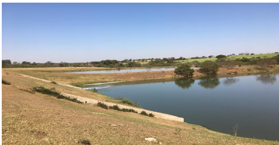
Foto 3.74 – Vista da primeira lagoa facultativa com a segunda lagoa ao fundo – ETE Barra Grande
