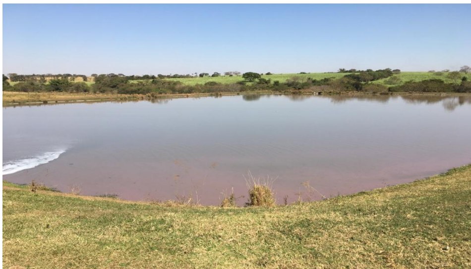
Foto 3.78 – Detalhe da coloração avermelhada da segunda lagoa facultativa
