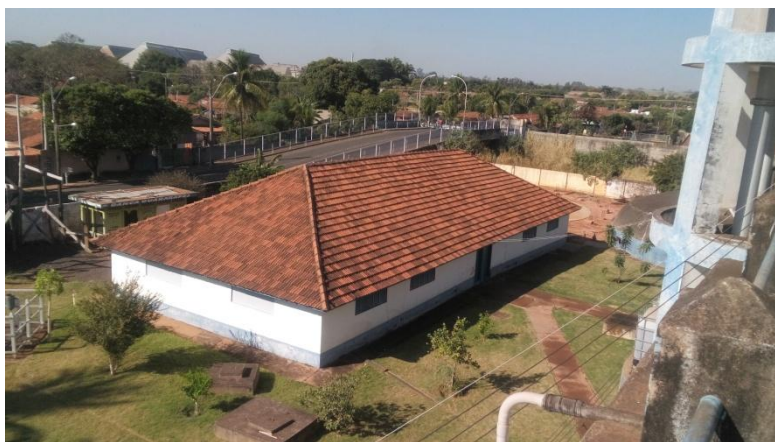
Foto 3.29 – Vista do Reservatório Enterrado de 350 m 3 localizado na ETA – Tanque de Contato
