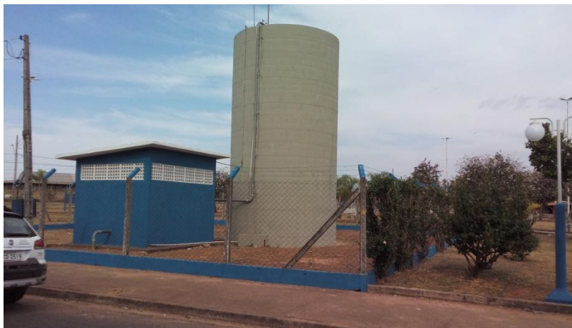
Foto 3.35 - Reservatório Lineu de Almeida de 100 m 3 .
