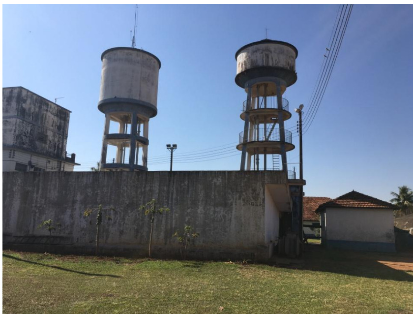
Foto 3.28 – Vista do posicionamento dos Reservatórios Elevados na ETA
