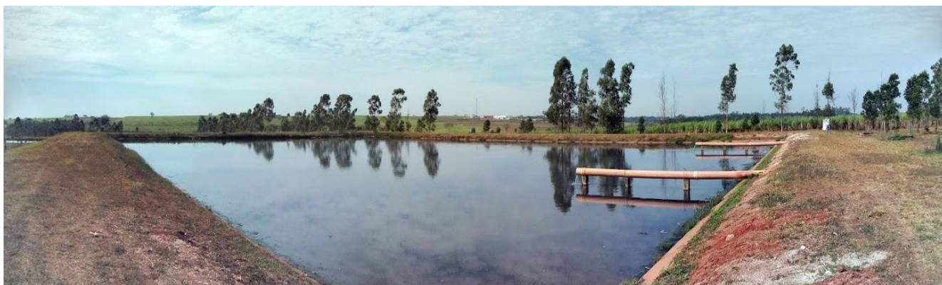
Foto 3.62 – Vista da Lagoa Anaeróbia – ETE Frutal
