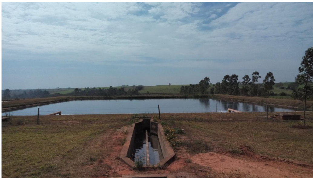
Foto 3.61 – Vista da Caixa de areia e da lagoa anaeróbia
