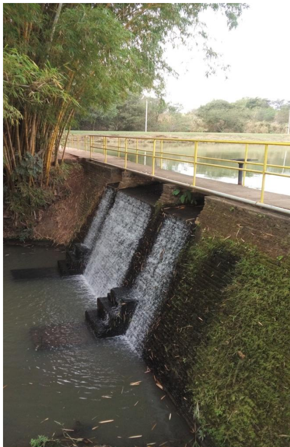
Foto 3.2 – Vista da barragem e do vertedouro da Represa 1
