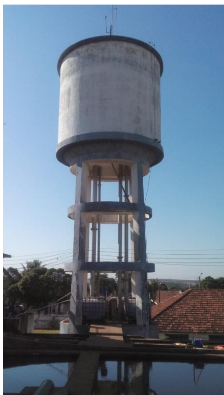
Foto 3.26 – Vista do Reservatório Elevado de 150 m 3
