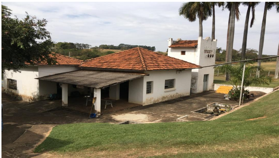
Foto 3.12 – Vista da EEAB
