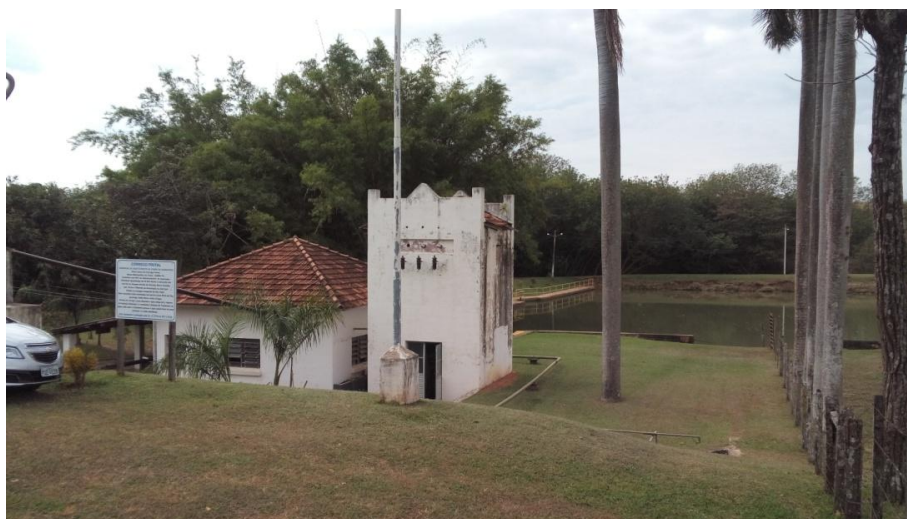
Foto 3.11 – Vista da EEAB e da entrada de energia
