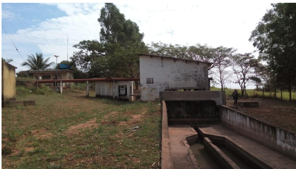
Foto 3.54 – Vista da EEE Final e da tubulação de recalque
