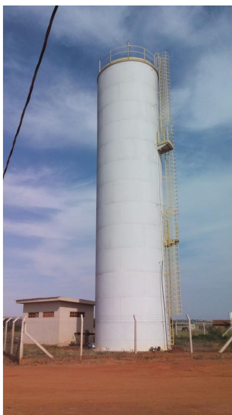
Foto 3.33 - Reservatório Jardim Itália
