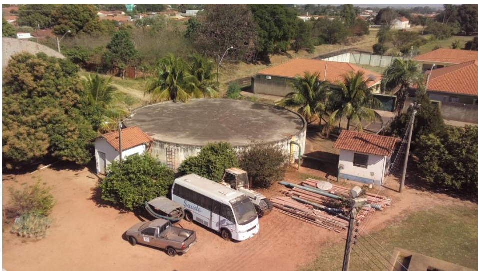
Foto 3.32 – Vista do Reservatório Semi-enterrado de 1.250 m 3 localizado na ETA
