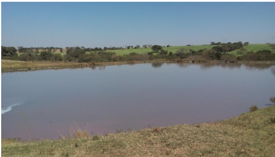
Foto 3.76 – Vista da segunda Lagoa Facultativa, detalhe da coloração avermelhada da água
