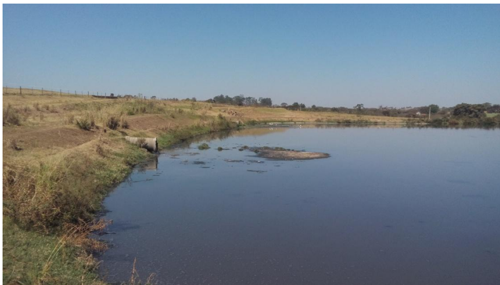
Foto 3.71 – Vista da Lagoa Anaeróbia da ETE Barra Grande
