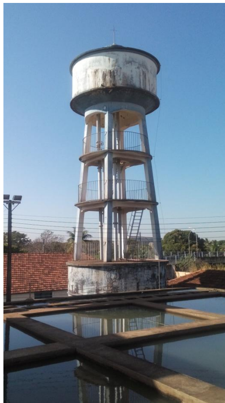
Foto 3.27 – Vista do Reservatório Elevado de 75 m 3
