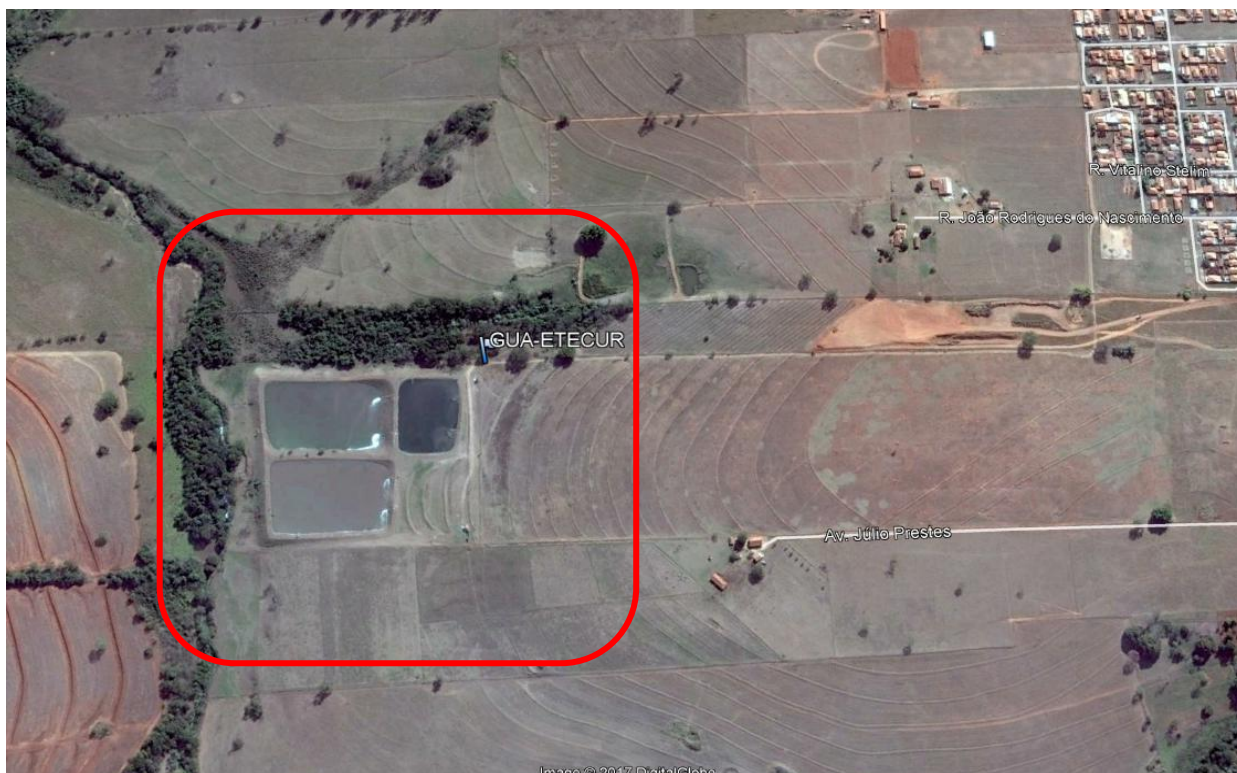
Foto 3.69 – Vista aérea da ETE Barra Grande
