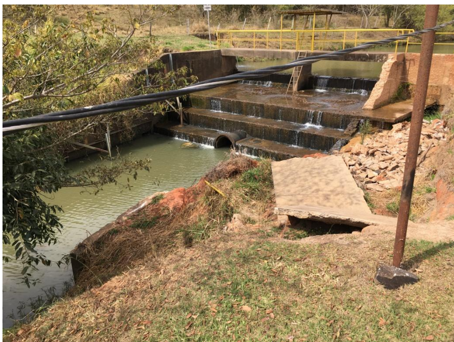
Foto 3.3 – Vista do vertedouro da barragem da Represa 2
