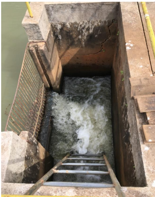
Foto 3.7 – Vista da captação da Represa 2
