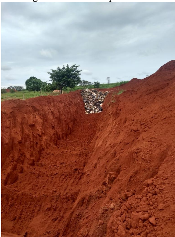
Figura 84 Vala sendo preenchida.
