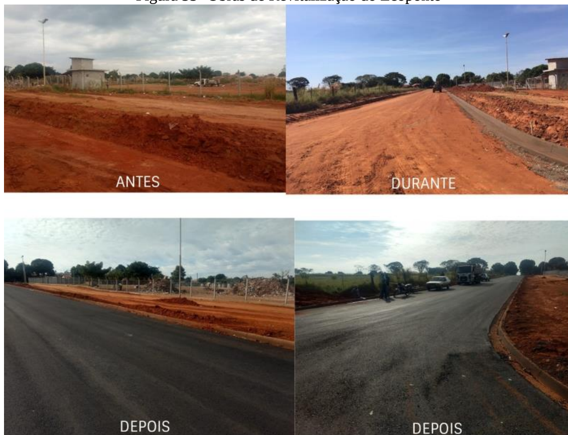
Figura 33- Obras de Revitalização do Ecoponto
