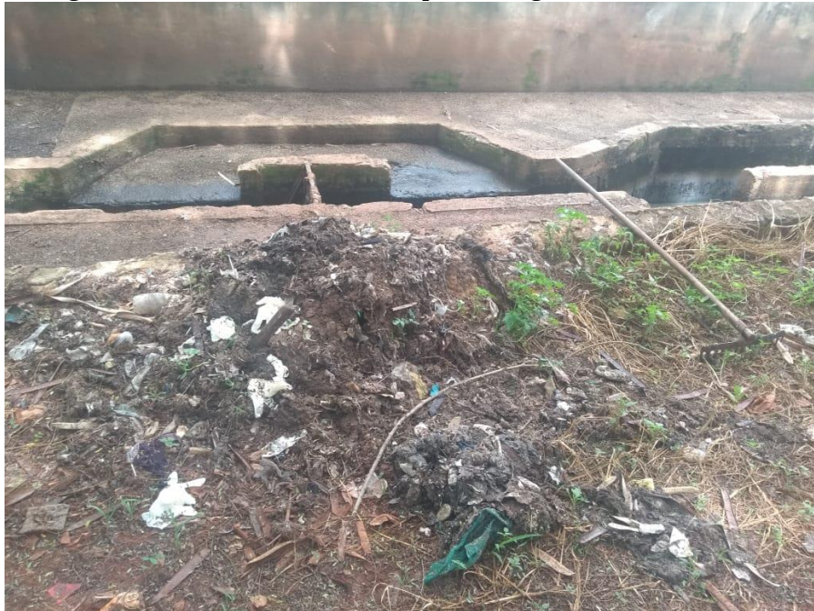
Figura 69 Resíduos retirados do primeiro gradeamento da ETE.
