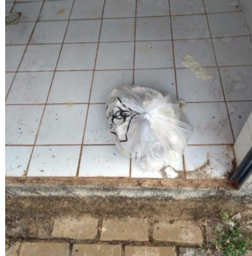
Figura 53 - Área interna do abrigo de RSS, com saco disposto no chão.
