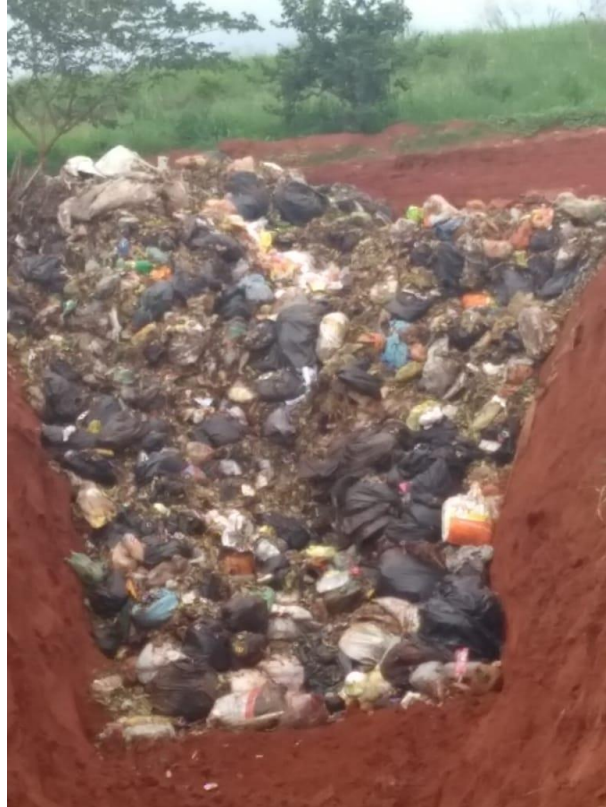
Figura 82 Vala escavada no Aterro sendo preenchida com Resíduos.
