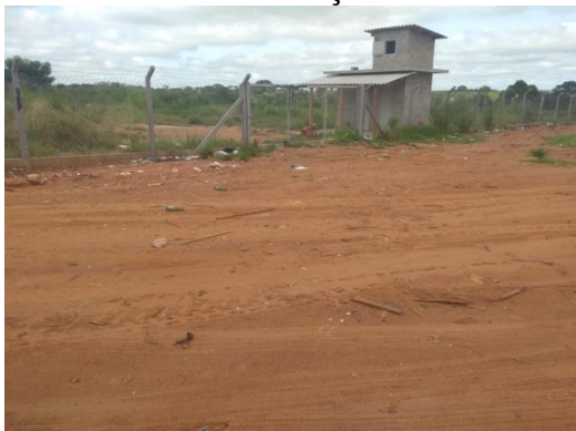
Figura 21 Ecoponto fechado em manutenção
