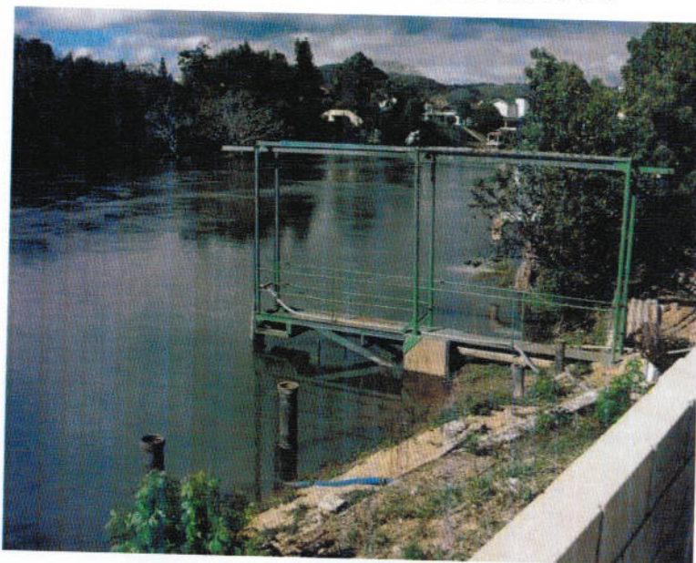
Figura 12: Captação no Rio Paraíba do Sul
