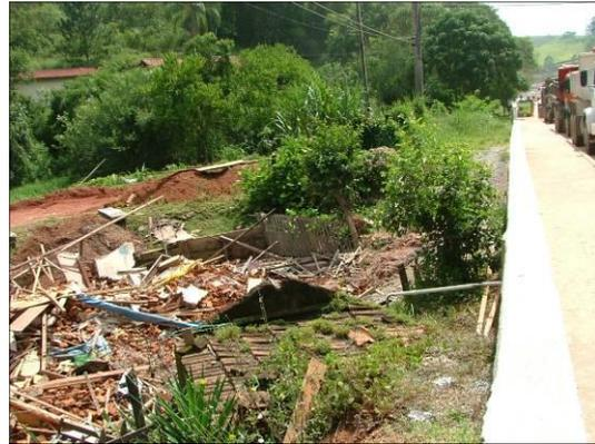
**Figura 35:** Resíduos da madeira que provocou entupimento da passagem de água.
