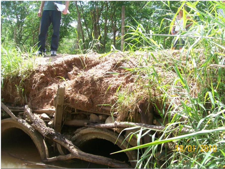
**Figura 61** - Vista da tubulação semi assoreada na passagem sob a Estr. Elvira Santana Cardoso.
