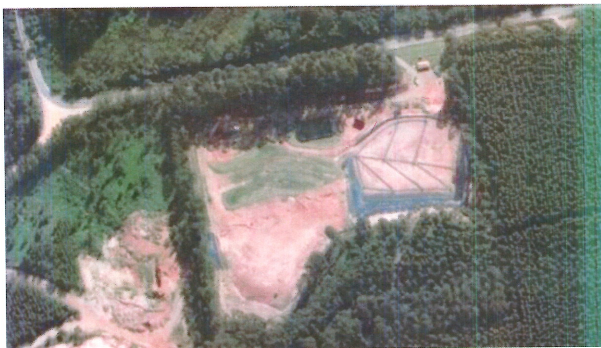
Figura 27 – Aterro Sanitário Municipal
