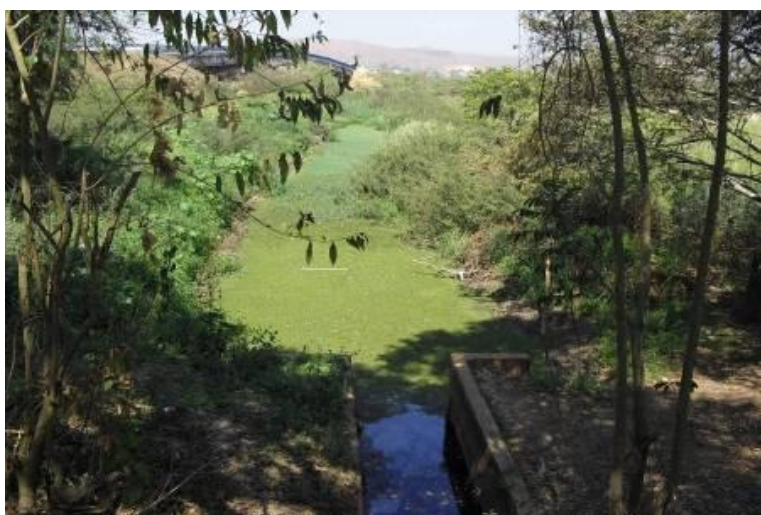
Foto 28 - Canal de Saída da Água em Direção ao Paraíba do Sul – Estação de Bombeamento do Rony.
