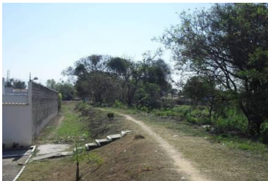
Foto 24 - Dique Situado no Loteamento do Nino – vista lateral - proteção do bairro contra as cheias do Ribeirão Guaratinguetá.
