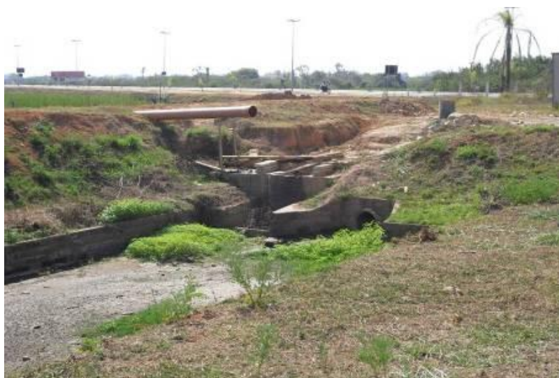
Foto 32 - Chegada das Tubulações de Drenagem das Águas Pluviais na Estação de Bombeamento Chácara Selles no Campo do Galvão.
