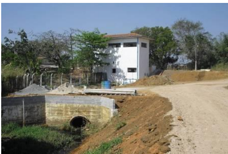
Foto 27 - Estação de Bombeamento do Rony (Polder Guaratinguetá) – recebe as águas das áreas de arroz e dos bairros Parque das Árvores, Nino e Rony.
