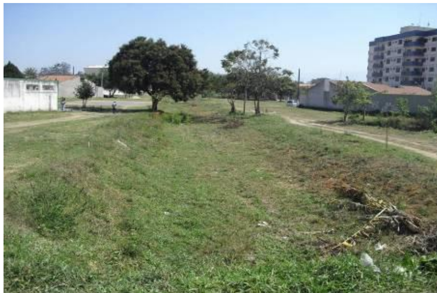
Foto 18 - Valeta de Coleta e Transporte das Águas Pluviais – Parque das Árvores.
