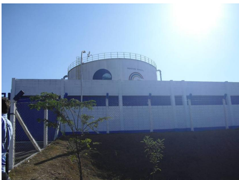
Foto 05 - Casa de bombas com o reservatório ao fundo – Parque São Francisco.
