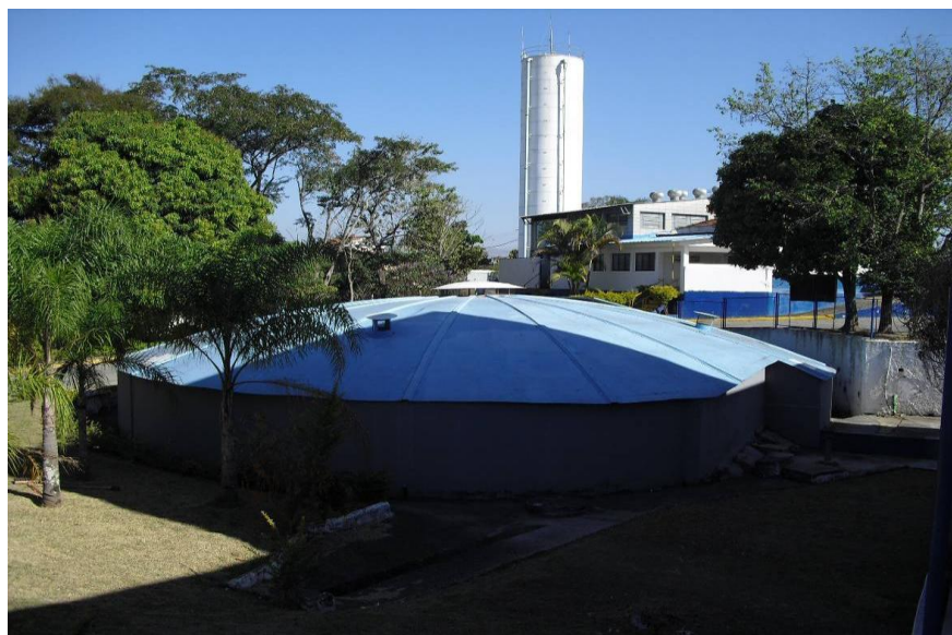
Foto 04 - Reservatório de Água Tratada nas Dependências da Estação de Tratamento de Água – SAEG.
