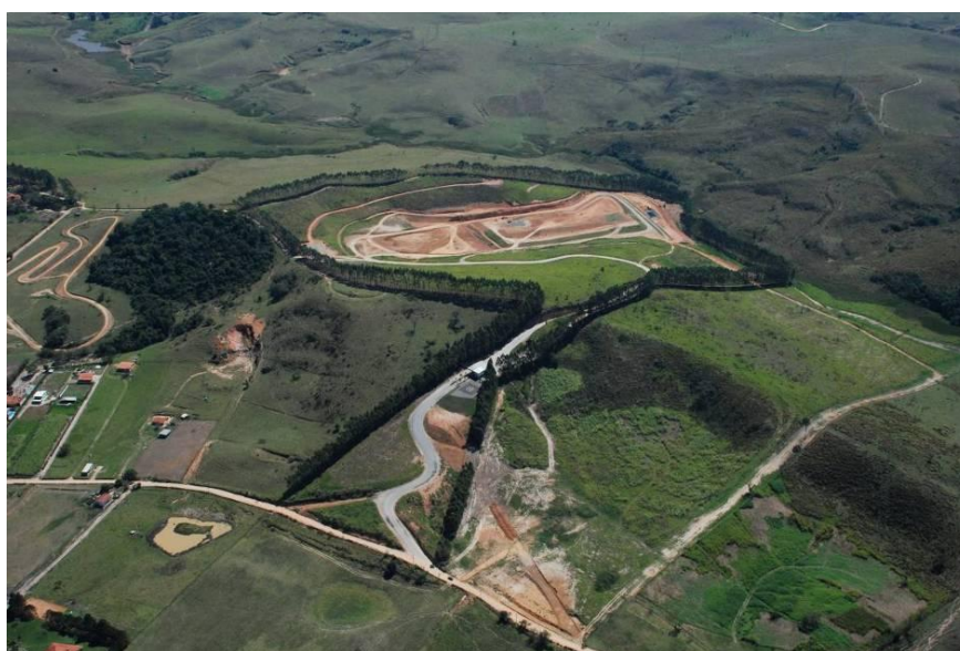
Foto 13 - Vista Aérea do Aterro Sanitário de Cachoeira Paulista (Fonte: VSA)
