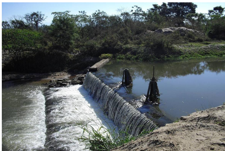
Foto 01 - Barragem de Nível para Captação – Ribeirão Guaratinguetá.
