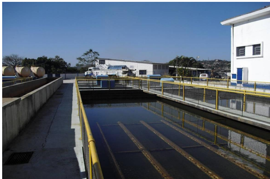
Foto 03 - Estação de Tratamento de Água – SAEG.
