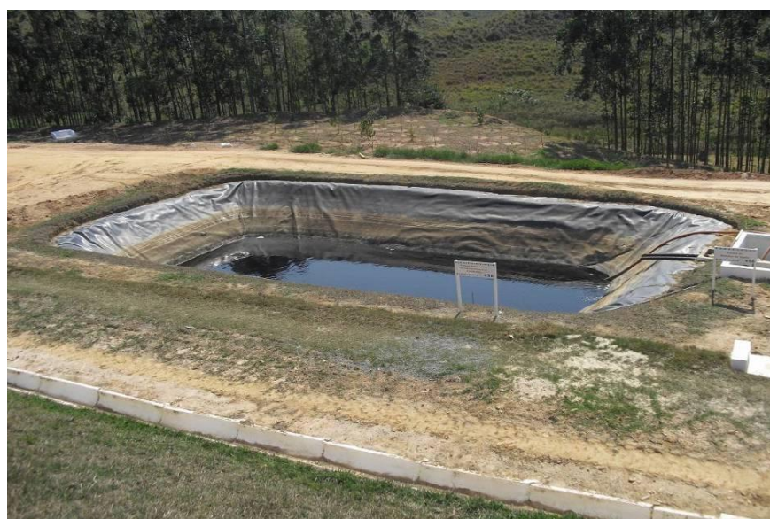
Foto 16 - Tanque Reservatório de Líquidos Percolados.
