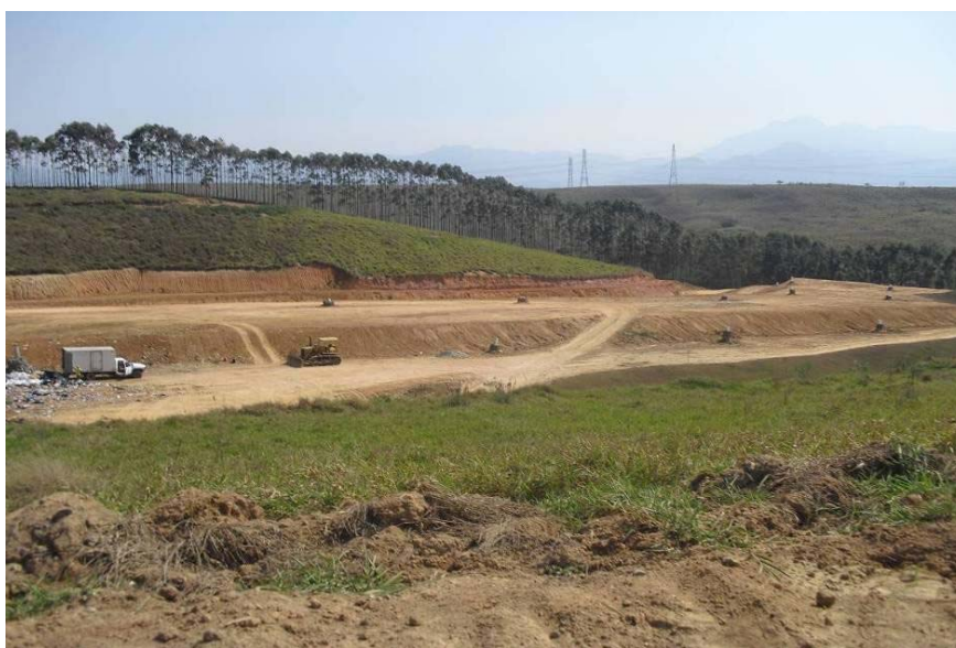
Foto 14 - Vista Geral do Aterro Sanitário de Cachoeira Paulista.
