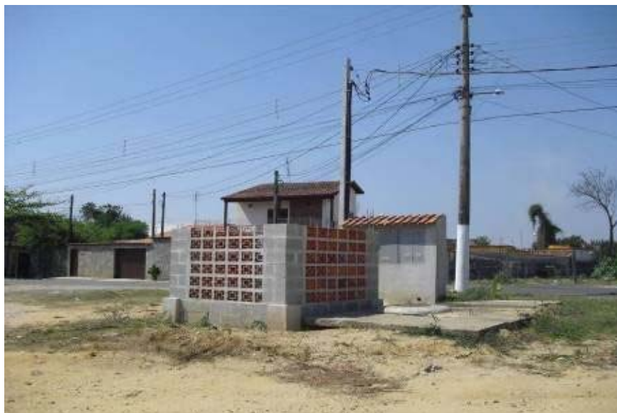
Foto 25 - Estação de Bombeamento Parque das Árvores.
