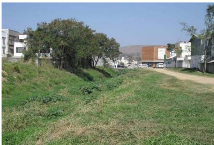
Foto 30 - Valeta de Drenagem que Conduz o Escoamento Superficial para a Estação de Bombeamento Gráfica Dias no Residencial Esplanada.
