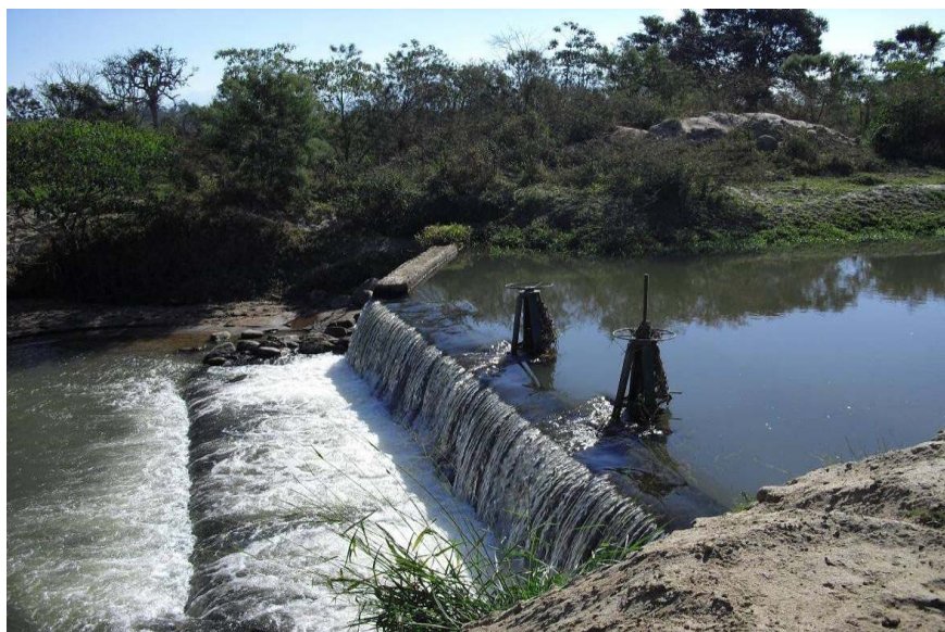
Foto 01 - Barragem de Nível para Captação – Ribeirão Guaratinguetá.
