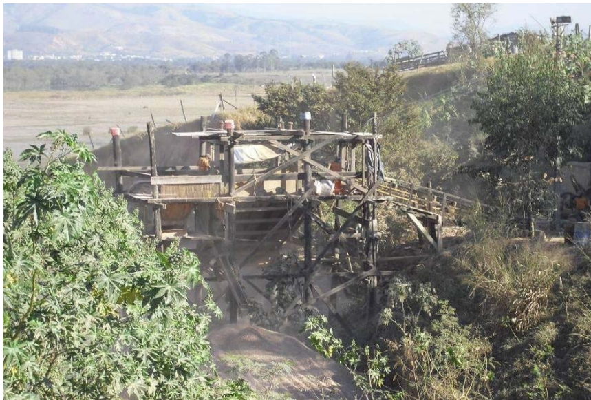
Foto 17 - Centro de Reciclagem de Resíduos da Construção Civil.
