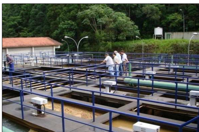
FIGURA 7 - Vista Geral da ETA Cabuçu
