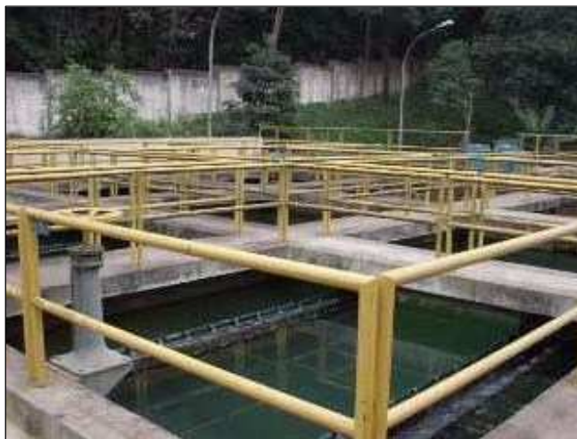
FIGURA 8 - Vista Geral da ETA Tanque Grande
