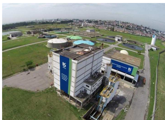
FIGURA 15: Vista aérea ETE São Miguel
