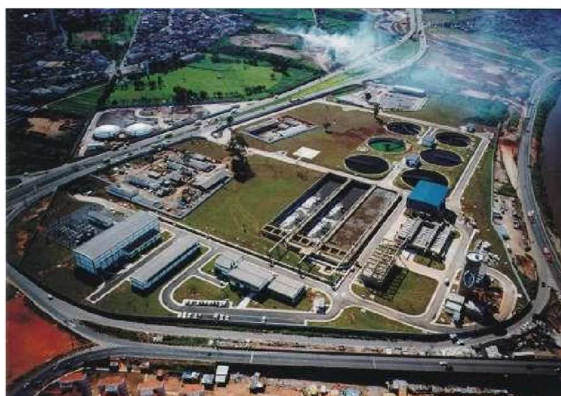
FIGURA 14: Vista aérea ETE Parque Novo Mundo
