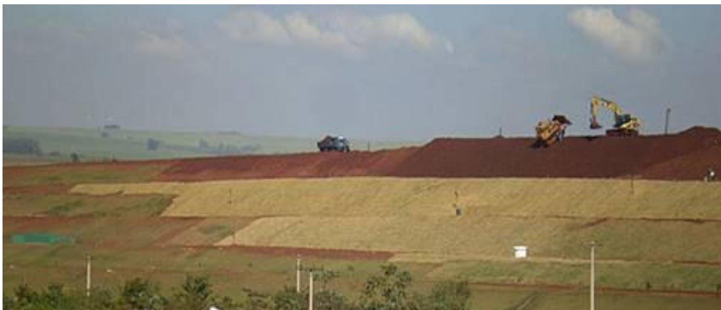
Figura 10.1.33. Regularização dos taludes e plantio de gramíneas.
