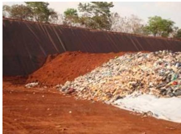
Figura 10.1.24. Impermeabilização lateral da célula
