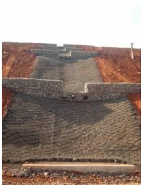
Figura 10.1.29. Sistema de drenagem pluvial
