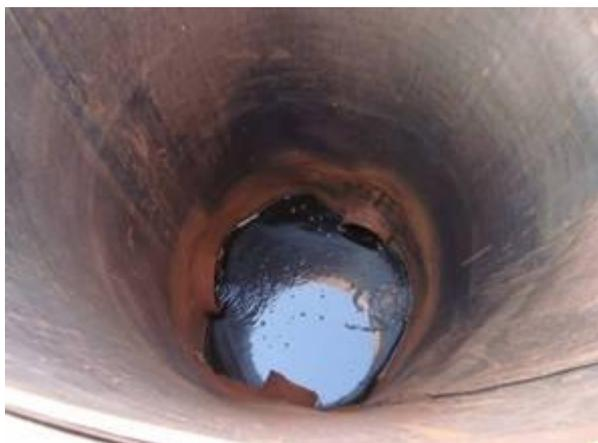
Figura 10.1.25. Sistema de captação de chorume
