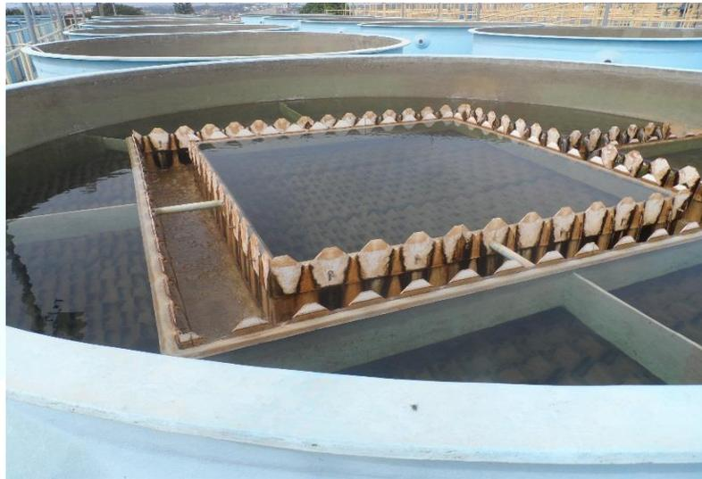
**FOTO 3: Decantadores Instalados Na ETA – JD. Boa Esperança.**
