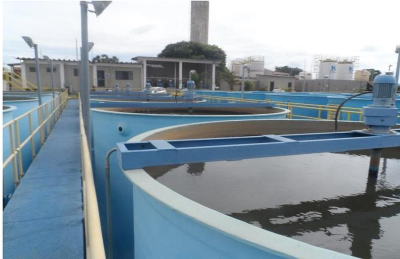
**FOTO 2: Floculador Mecânico Instalado Na ETA – JD. Boa Esperança.**
