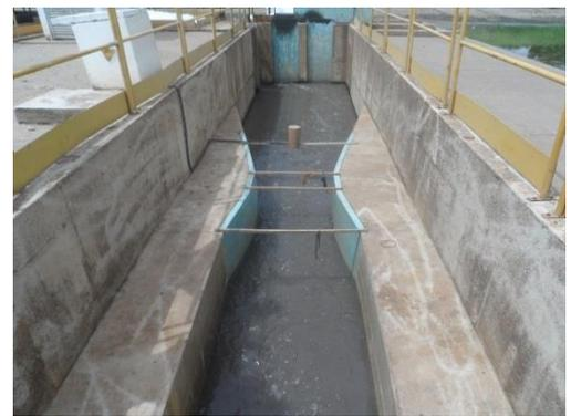
**FOTO 13: Tanque De Contato De Cloro E Calha Parshall De Esgoto Tratado Com Medidor De Vazão Online.**
