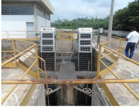
**FOTO 10: Tratamento Preliminar - Sistema De Gradeamento Mecanizado (Elevatória De Esgoto Bruto).**
