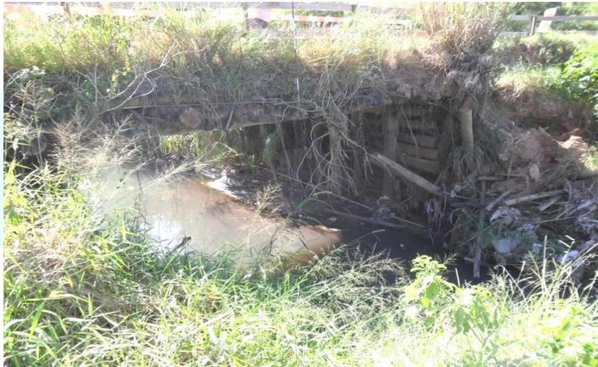
**FIGURA 70: Travessia Com Paredes Laterais De Madeira E Fundo De Terra, Péssimo Estado De Conservação.**
