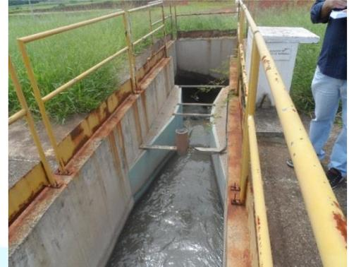
**FOTO 11: Tratamento Preliminar-Sistema De Gradeamento Fino Mecanizado E Calha Parshall Com Medidor De Vazão Online.**
