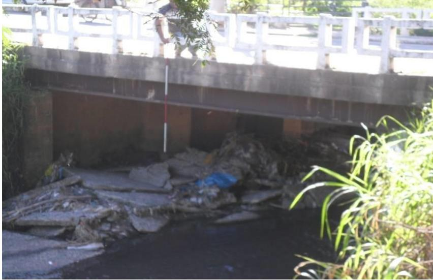
**FIGURA 69: Ponte Vila Inema, Más Condições De Conservação E Assoreamento Por Entulhos.**
