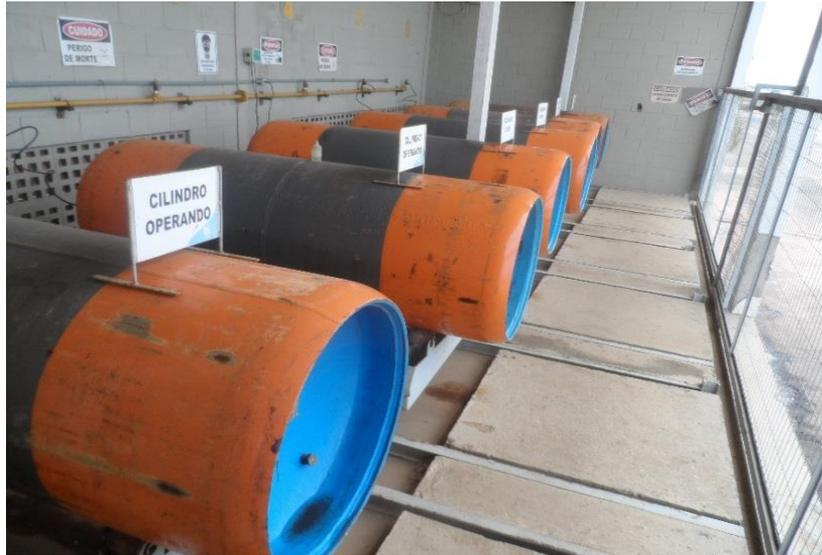
**FOTO 5: Armazenamento De Cloro Gás Utilizado Na ETA – JD. Boa Esperança.**
