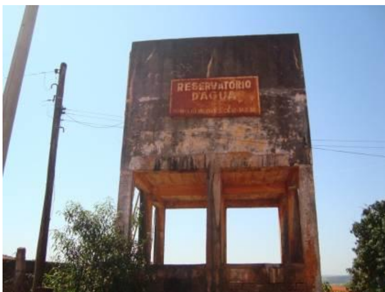
Figura 27. Reservatório elevado de concreto 64 m 3
