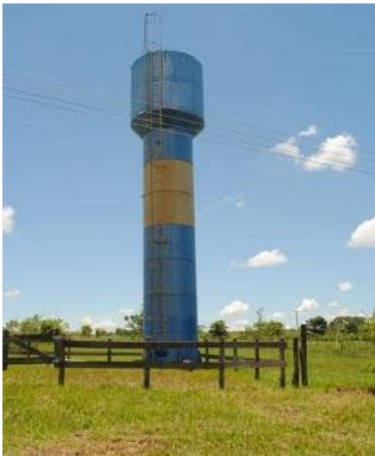
Figura 26. Reservatório elevado metálico – Distrito Quilombo
