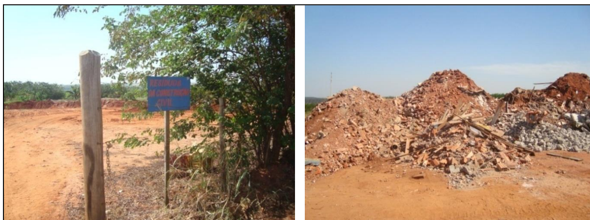
Figura 141. Local e vala destinados à deposição dos Resíduos da Construção Civil
