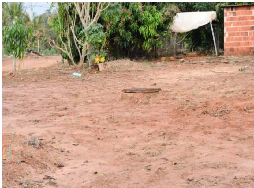
Figura 44. Fossa séptica do loteamento Recanto dos Tucunarés
