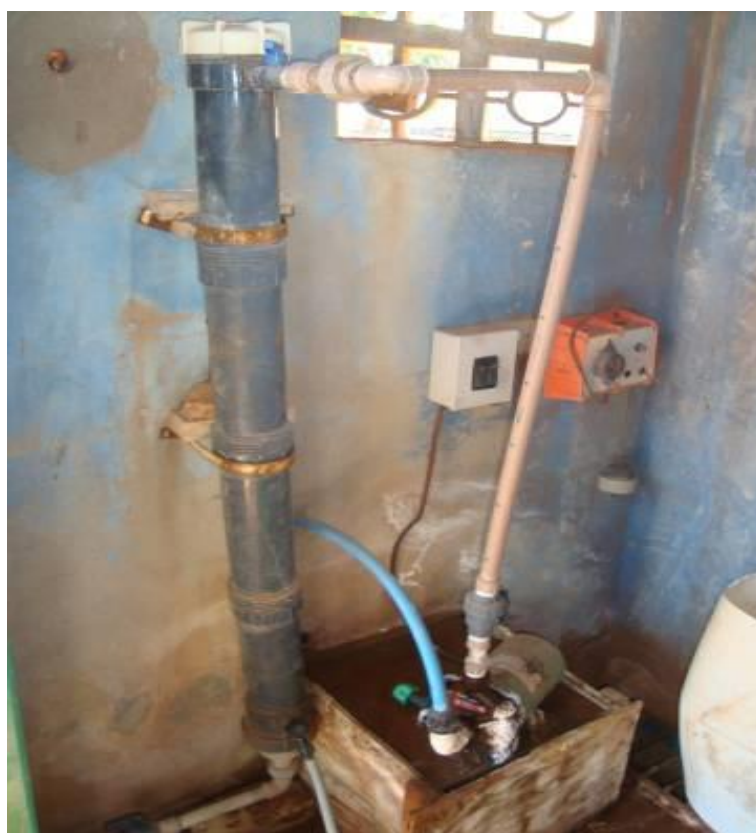
Figura 18. Cloração e fluoretação
