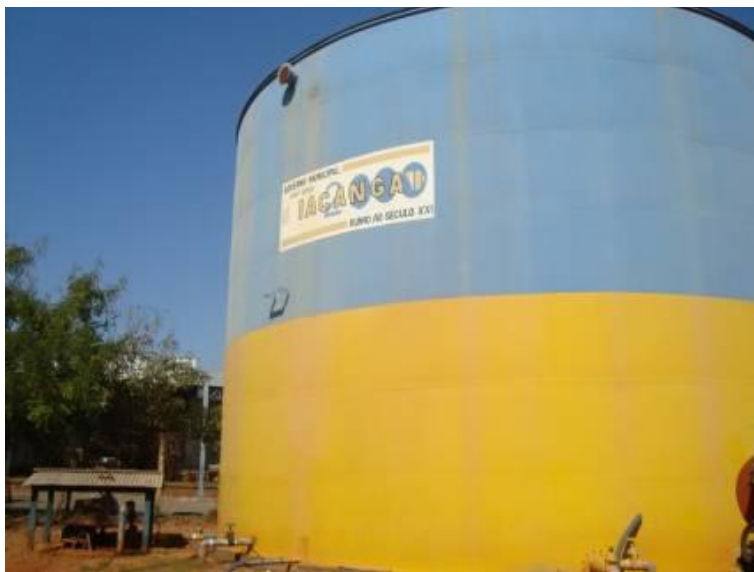
Figura 28. Reservatório apoiado metálico 1.000 m 3
