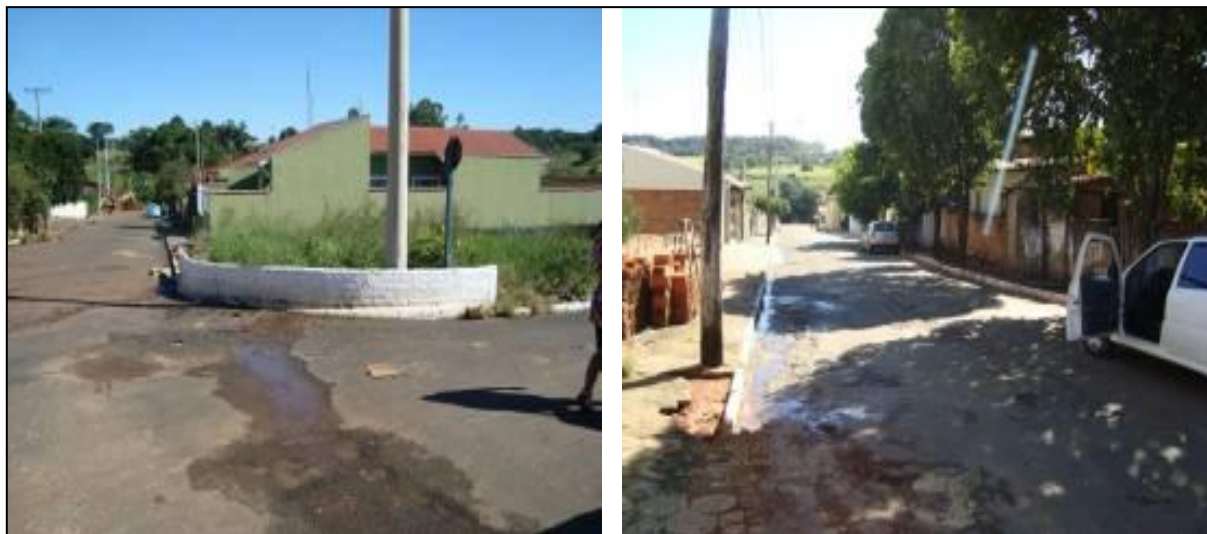
Figura 68. Alagamento de terrenos e destruições diversas na Rua Laemert Garcia dos Santos, esquina com a Rua Bauru e adjacências
