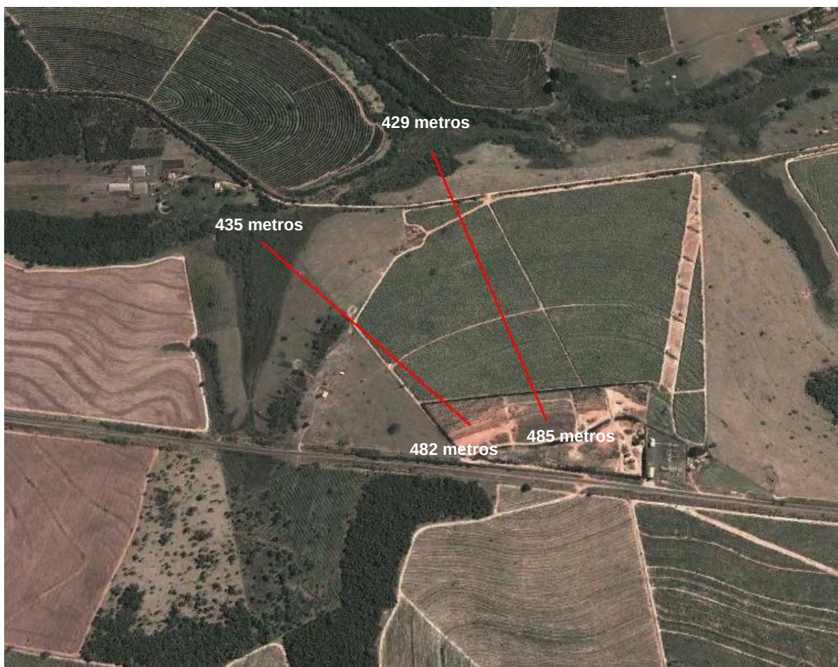
Figura 179: Declividade da área do entorno do aterro em valas
