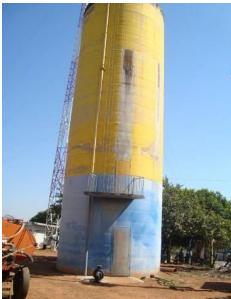
Figura 25. Reservatório elevado de concreto 150 m³
