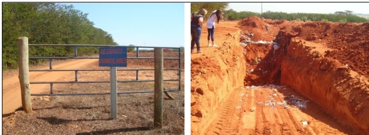
Figura 110. Área de deposição dos resíduos domiciliares
