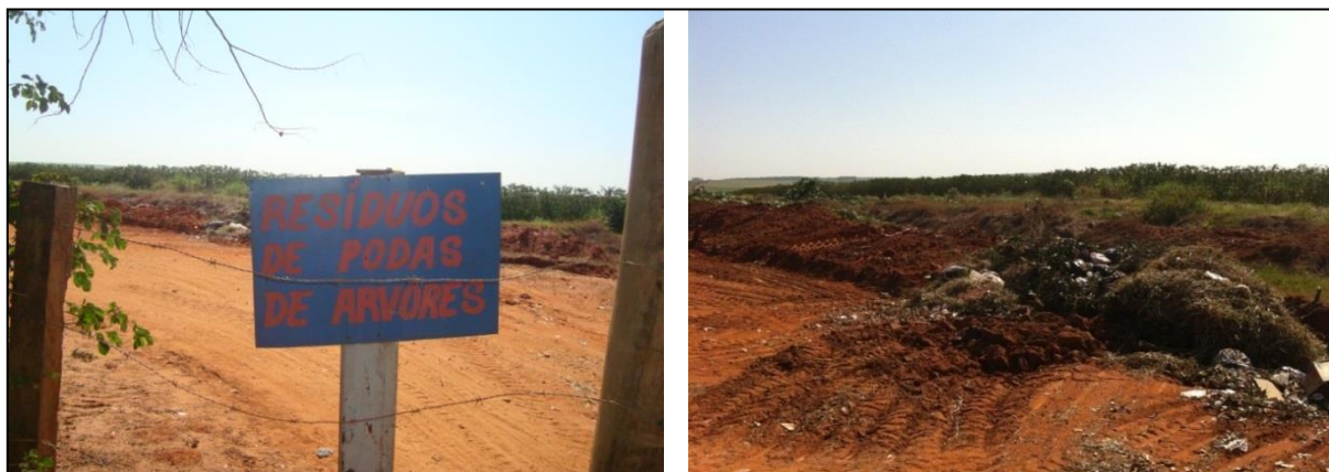
Figura 129. Local e vala destinados à deposição dos resíduos de podas, galhos e varrição
