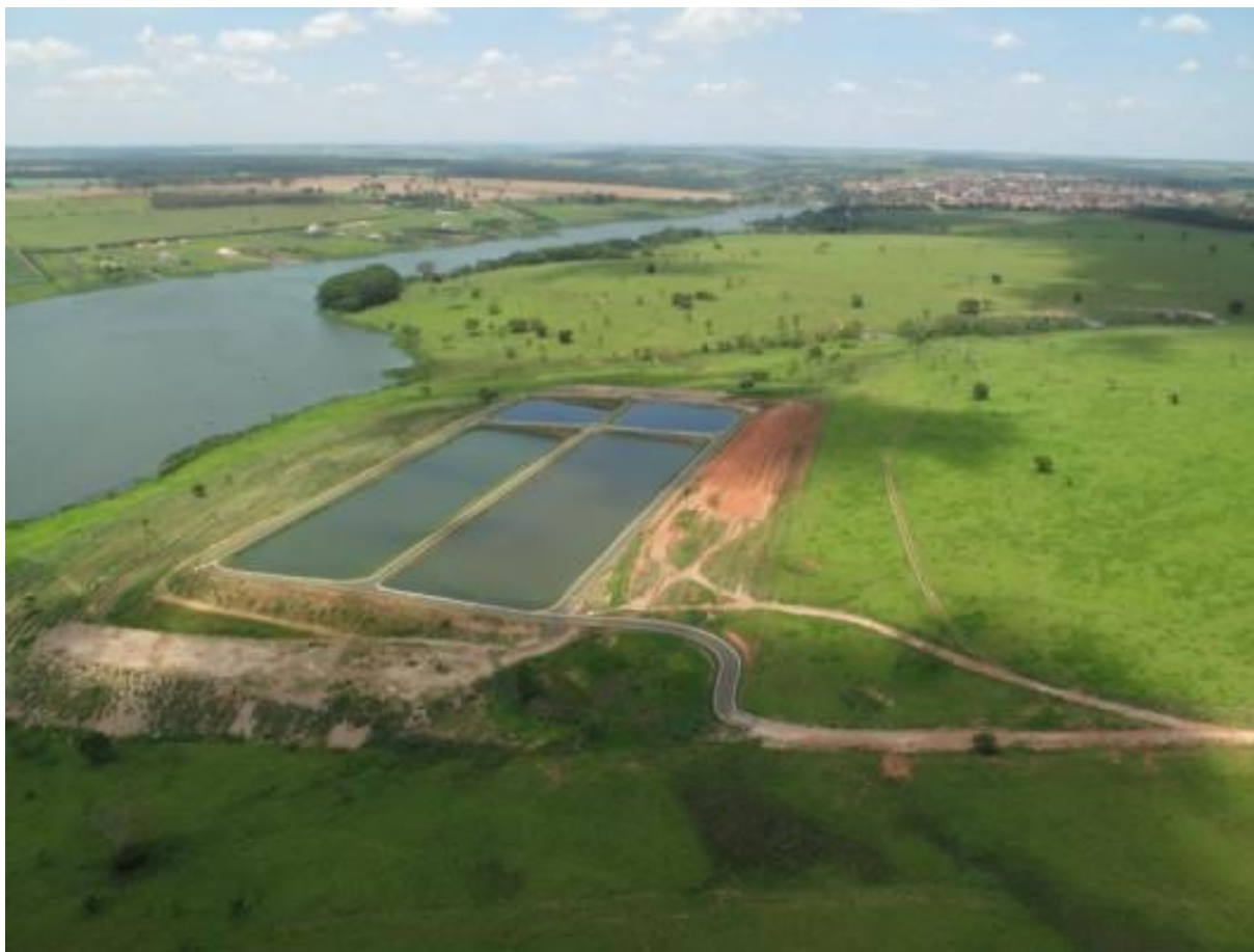
Figura 39. Imagem aérea da ETE de Iacanga
