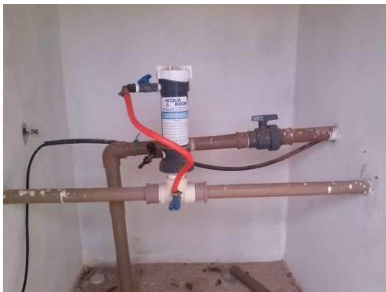
Figura 16. Cloração da água no poço do Distrito São Vicente
