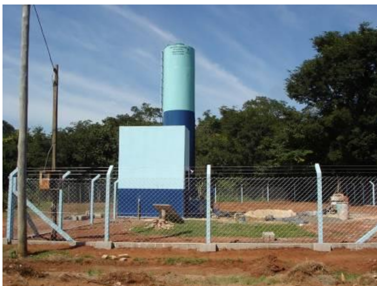
Figura 29. Reservatório elevado metálico – Distrito São Vicente
