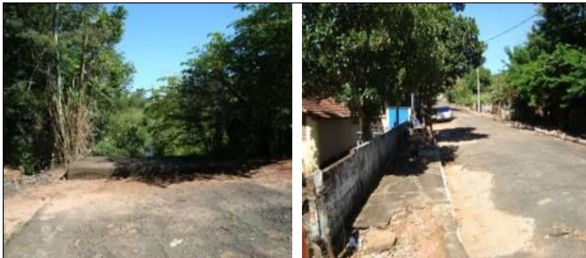
Figura 69. Trecho de alagamento na Rua Almirante Barroso esquina com a Rua 9 de Julho e adjacências
