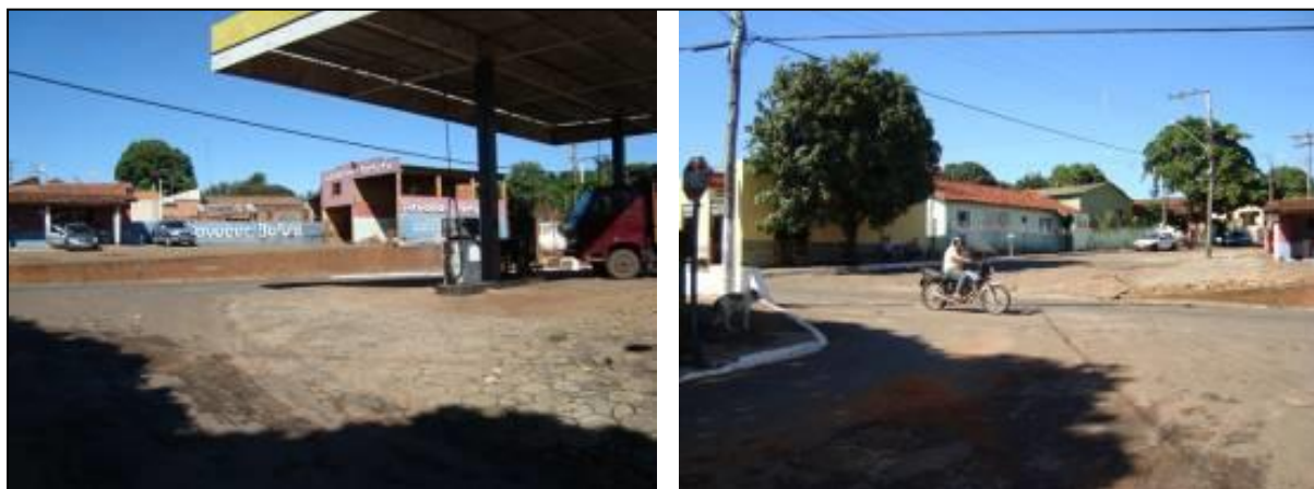
Figura 67. Alagamento de terrenos e destruições diversas na Rua Laemert Garcia dos Santos, esquina com a Rua Bauru e adjacências
