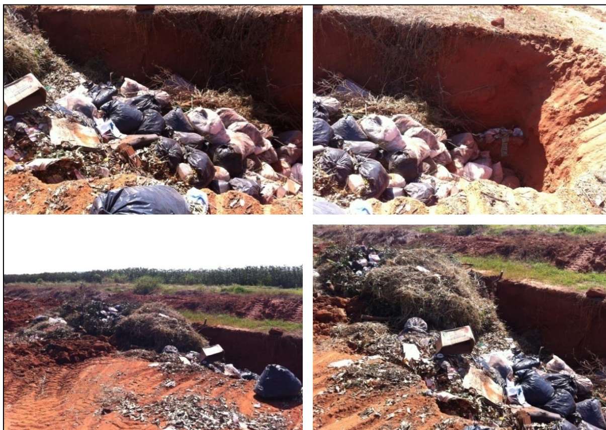
Figura 130. Vala destinada ao depósito dos resíduos da varrição de ruas
