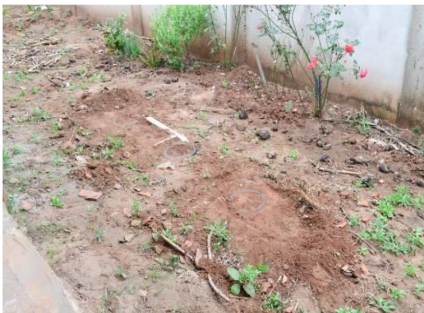
Figura 45. Fossa séptica do loteamento Praia dos Sonhos
