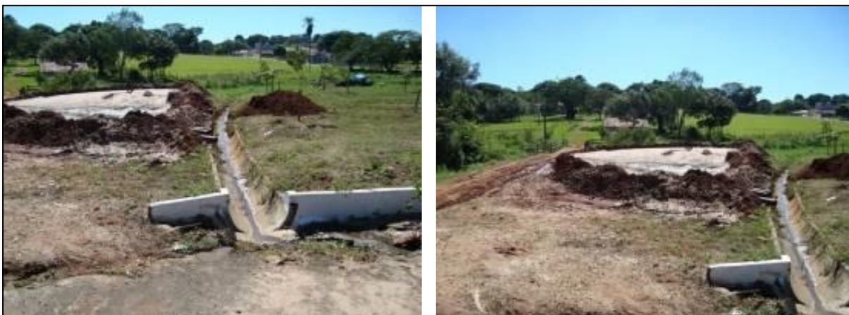
Figura 63. Alagamento e erosão na Avenida Dr. Jonas Nunes Brigagão e Rua Antônio Chechim
