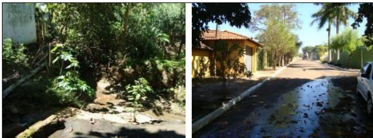
Figura 64. Alagamento com erosão e destruição de pavimento na Rua Dr. Sebastião de Paula Xaxier
