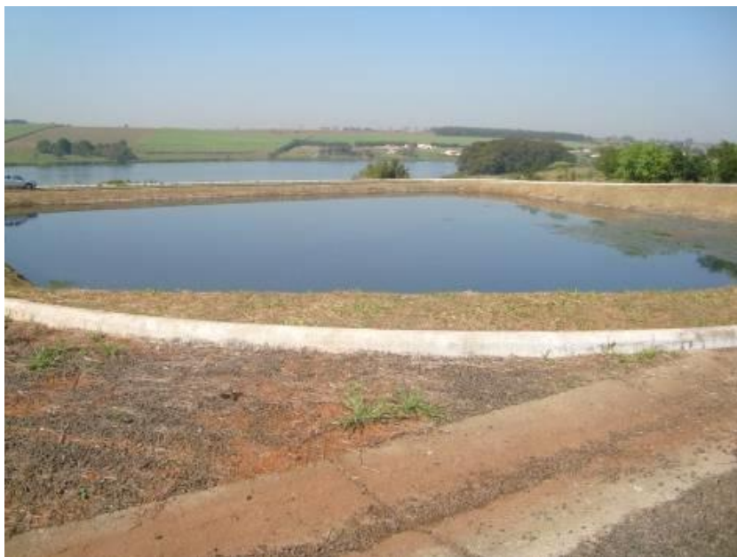
Figura 40. Lagoa anaeróbia
