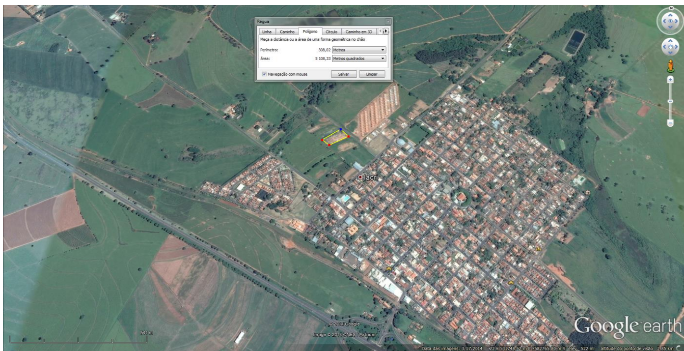
IMAGEM 20 – vista ampla do local destinado à implantação de ATT.
