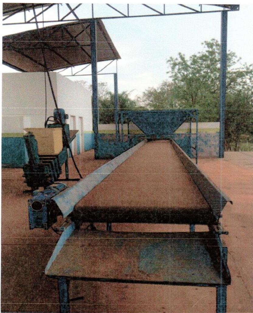
Figura 06: Prensa e esteira no galpão municipal de triagem
