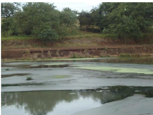
Foto 3.29 – Problemas de assoreamento e no revestimento de concreto – Lagoa facultativa
