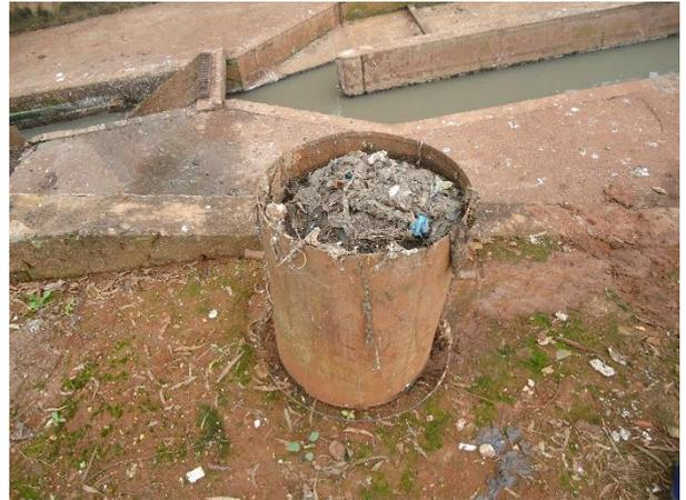
Foto 3.26 – Acondicionamento dos resíduos retirados das grades
