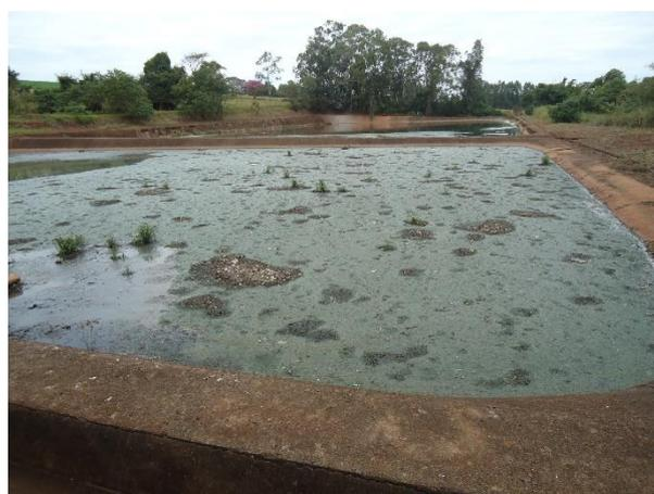
Foto 3.28 – Problemas de assoreamento – Lagoa anaeróbica
