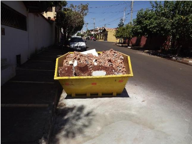
**Foto 6.13 – Caçamba de acondicionamento de RCC.**
