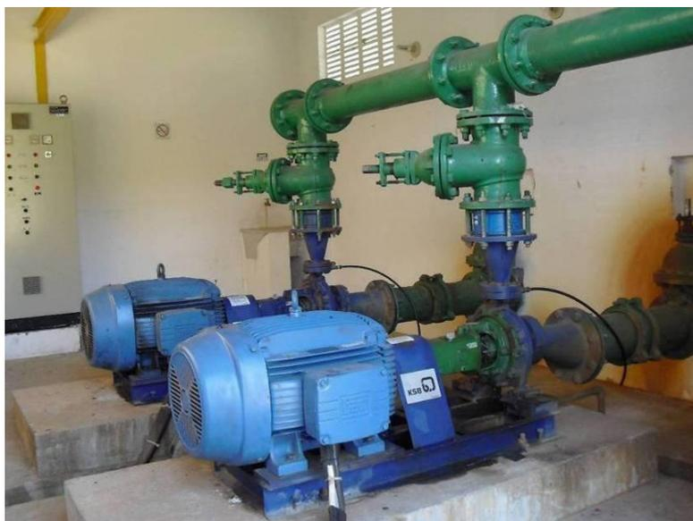
**Foto 03 – Estação Elevatória de Água Bruta**
