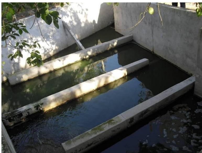
Foto 13 – Tanque de contato do efluente final – ETE de Igaratá
