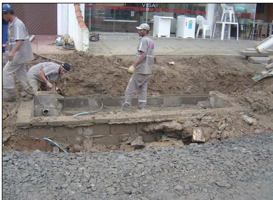
Foto 3 – Reparo da microdrenagem, com captação e galeria, na avenida principal de Iguape
