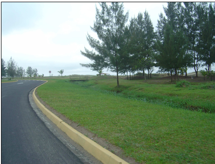
Foto 1 – Vala de Drenagem ao Longo da Avenida Oceânica e Paralela a Praia
