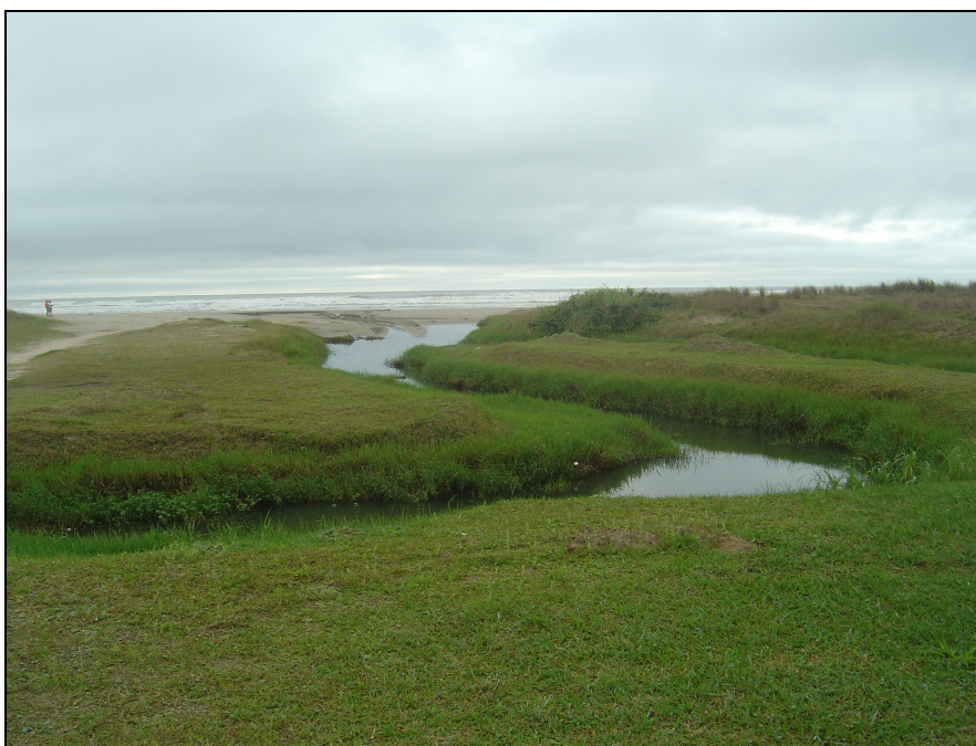
Foto 2 – Encaminhamento das Águas Pluviais por meio de Valas de Drenagem até o Mar
