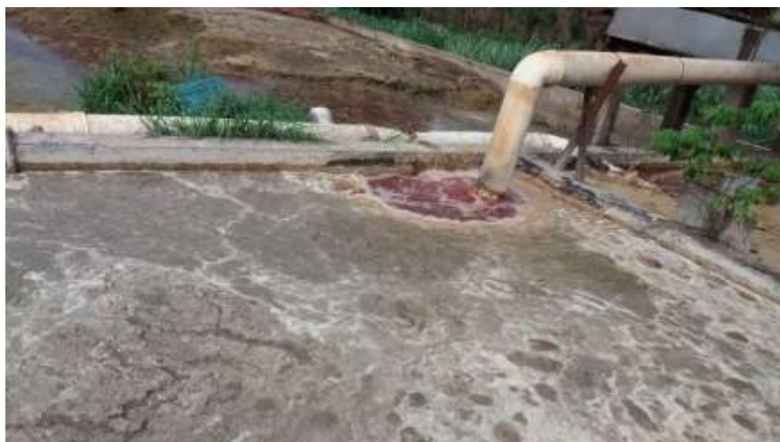
Figura 126. Registro do tratamento do efluente por sistema de lagoas
