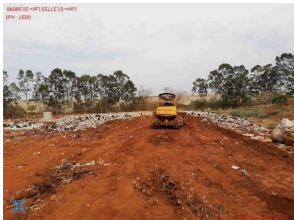
Figura 37. Aterramento e compactação dos resíduos na célula em operação.
