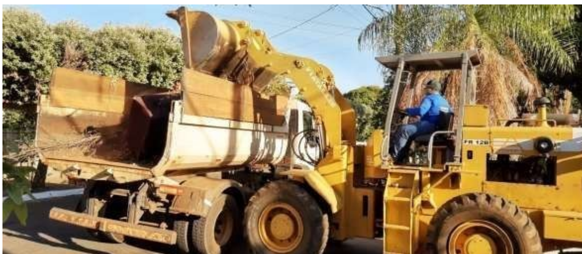
Figura 84. Limpeza urbana – retirada de galhos da via pública.
