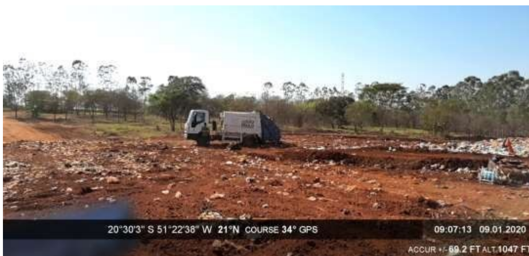
Figura 20. Disposição dos resíduos sólidos domiciliares pré-compactados na célula em uso.
