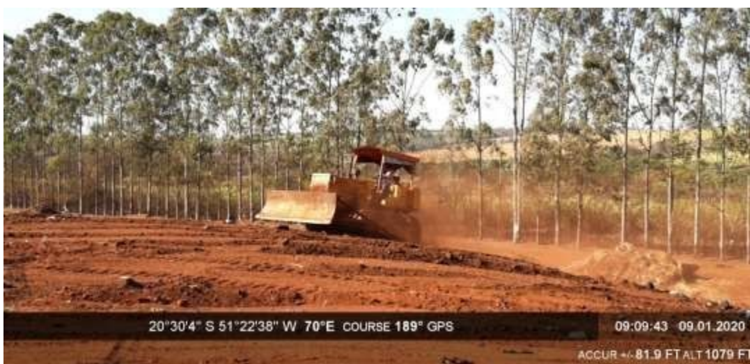
Figura 21. Compactação e cobertura da célula sendo realizada pelo trator esteira .
