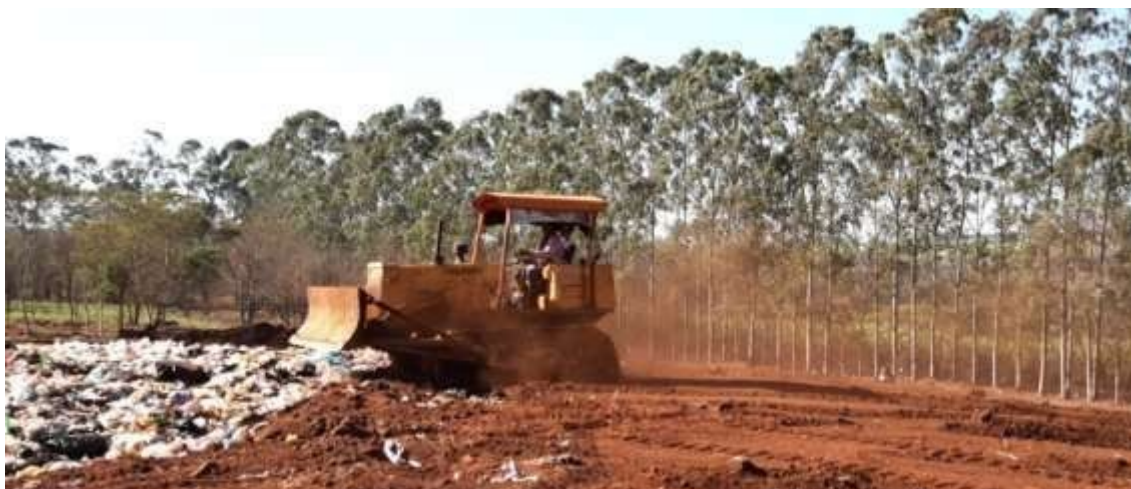
Figura 38. Aterramento e compactação dos resíduos sólidos domiciliares.
