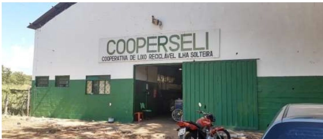
Figura 55. Fachada do Galpão de triagem da Cooperativa de Catadores Cooperseli.
