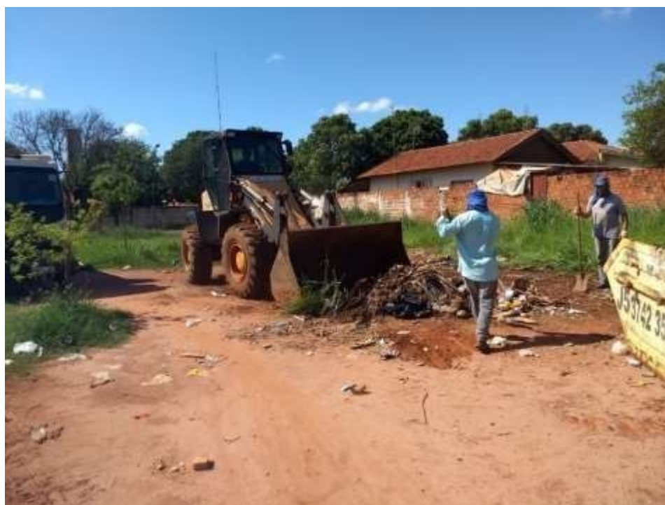
Figura 86. Prefeitura Municipal realizando a remoção de galhos e entulhos.
