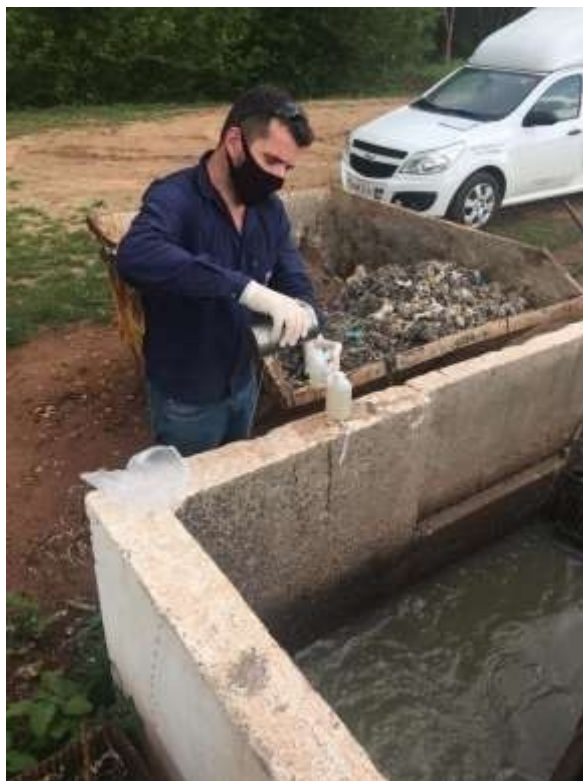
Figura 114. Registro da caçamba de rejeitos oriundos da limpeza do sistema de gradeamento durante realização da análise do efluente.
