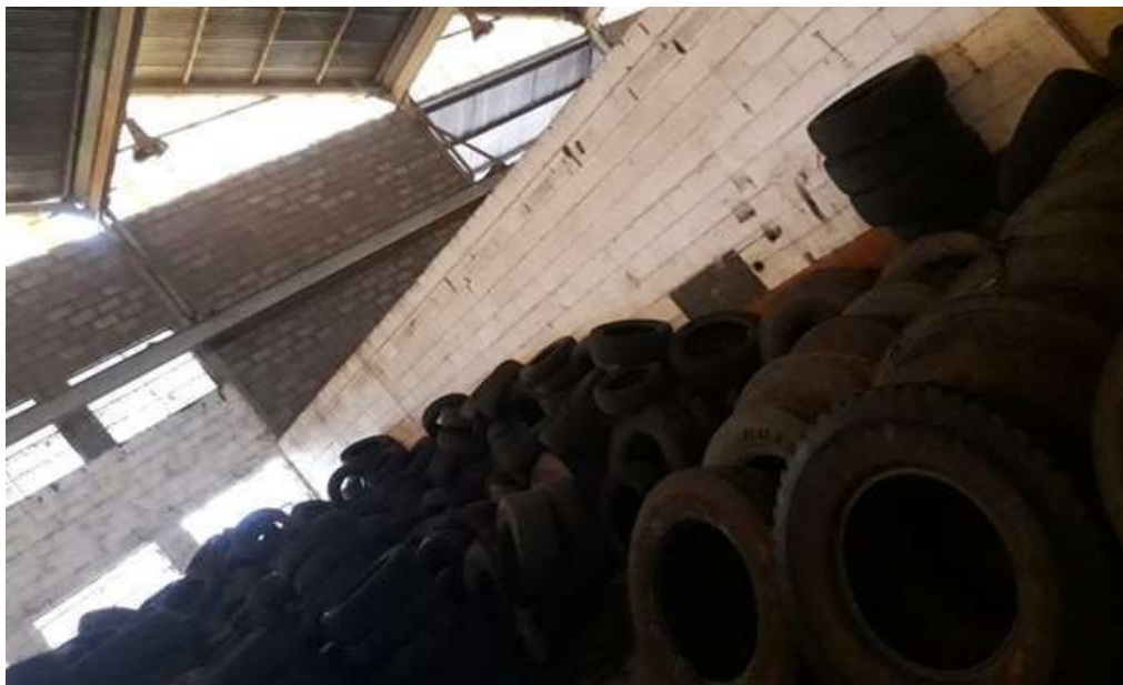
Figura 138. Registro do local de armazenamento de pneus.
