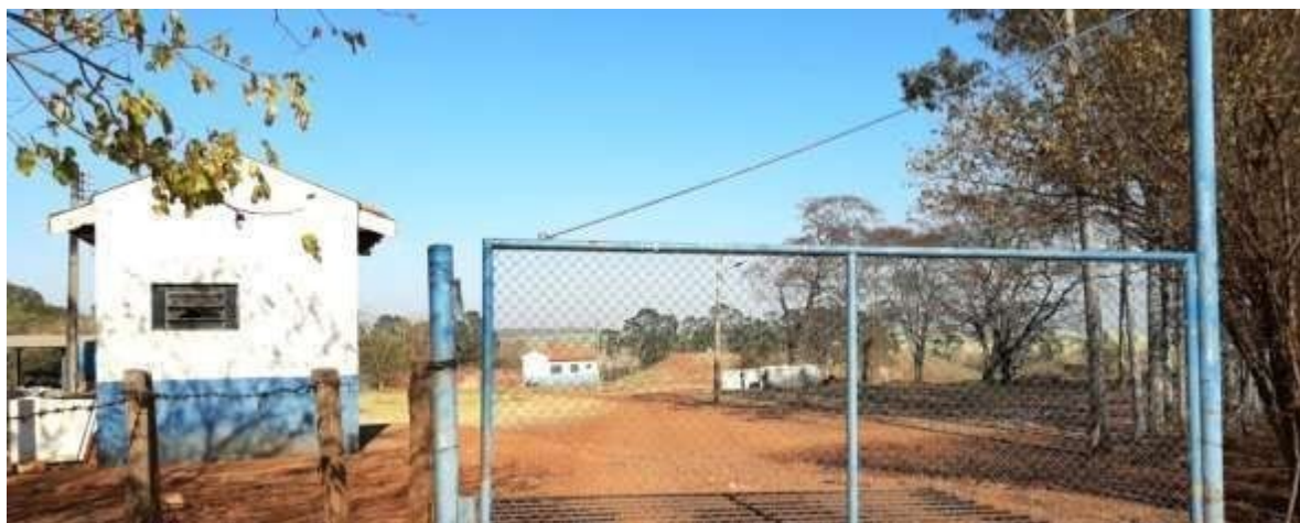
Figura 26. Guarita próxima ao portão de acesso.
