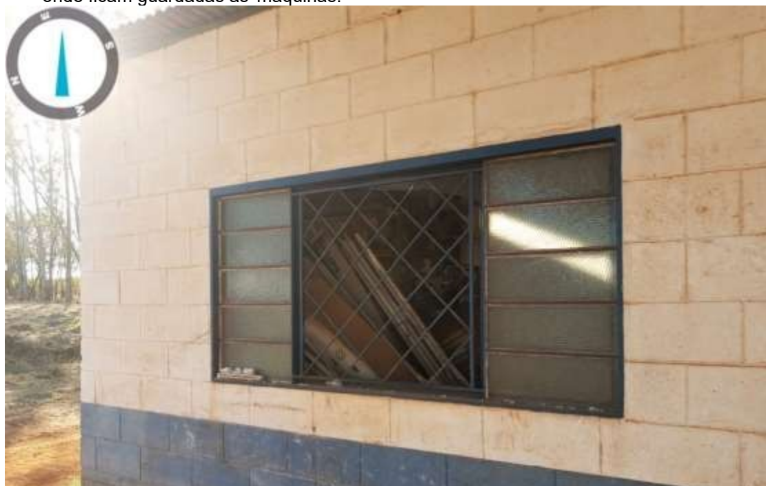
Figura 28. Local de armazenamento temporário de lâmpadas fluorescentes dentro do barracão onde ficam guardadas as máquinas.
