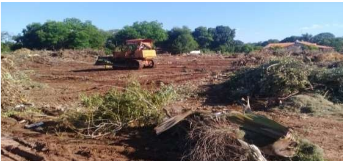
Figura 90. Disposição dos resíduos de poda sobre o solo.
