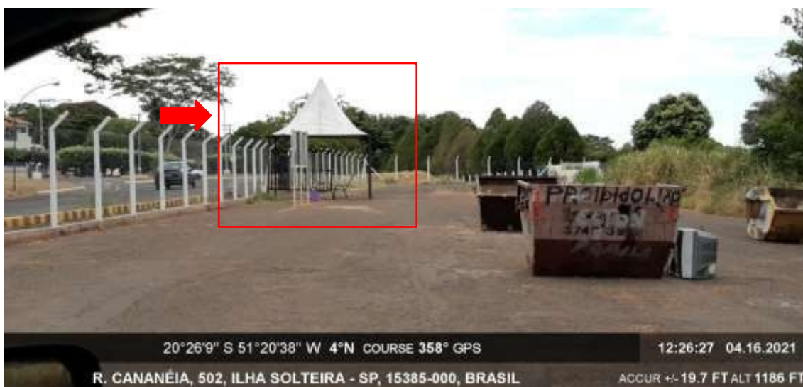
Figura 104. Registro interno do Ecoponto, com detalhe para o controle de entrada e saída.
