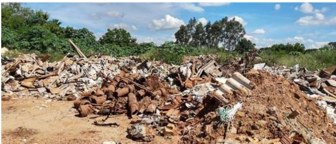
Figura 107. Acúmulo de resíduos de construção e demolição.
