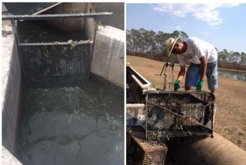
Figura 113. Registro da limpeza do sistema de gradeamento e retirada dos resíduos.
