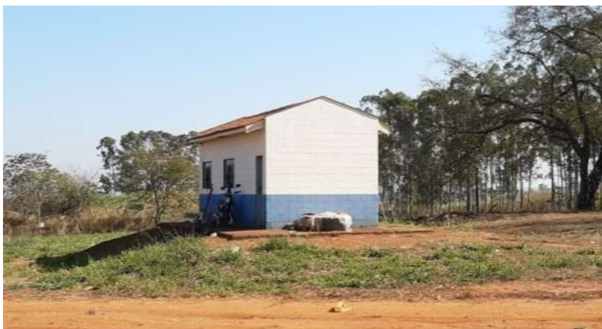
Figura 27. Escritório de Apoio, utilizado para guardar equipamentos
