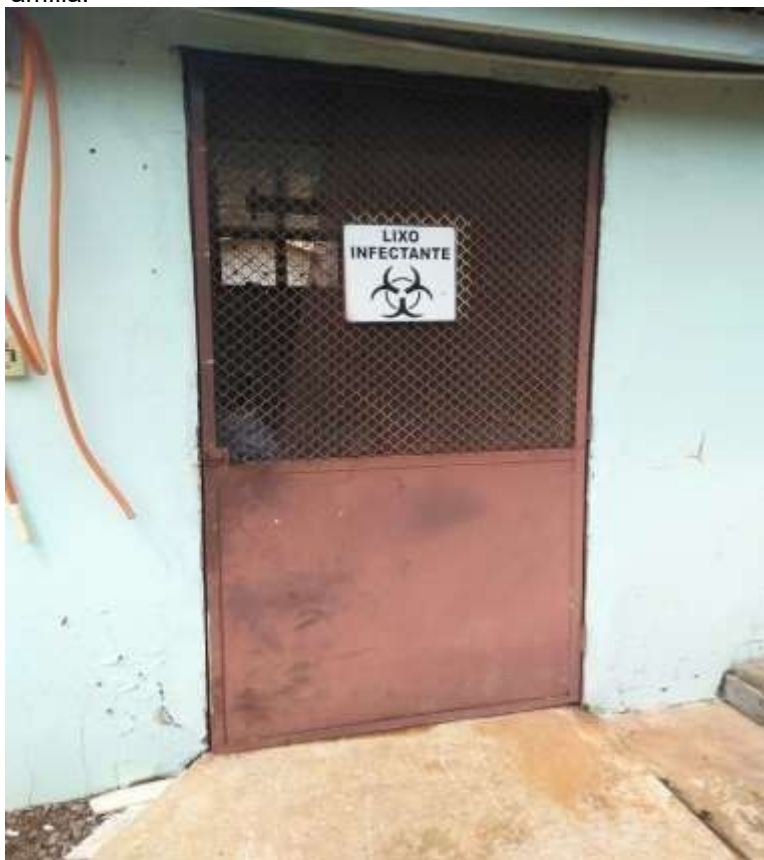
Figura 63. Registro do local de armazenamento temporário dos resíduos de saúde em uma das Unidades Básicas de Saúde da Família.
