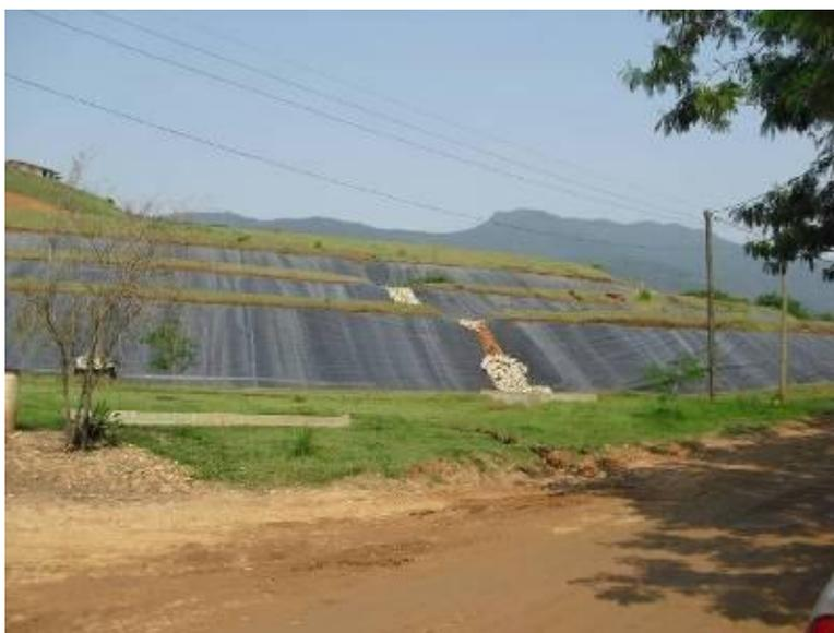
Foto 05 – Vista dos taludes revestidos por manta plástica impermeabilizante
