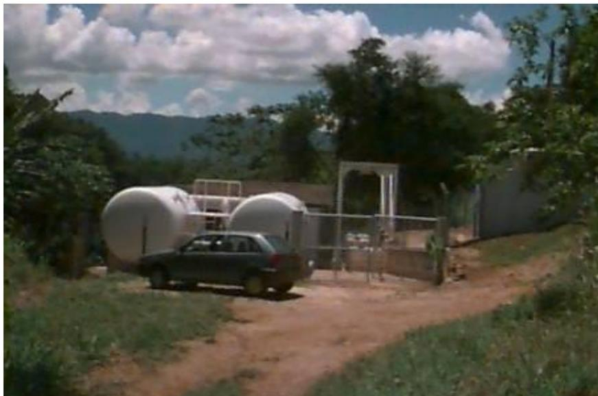
Foto 01 – ETA Pombo - Filtros pressurizados horizontais (Fonte: ETEP/2005)
