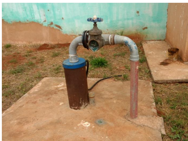
Foto 3.5 - Identificação do Poço: P6
