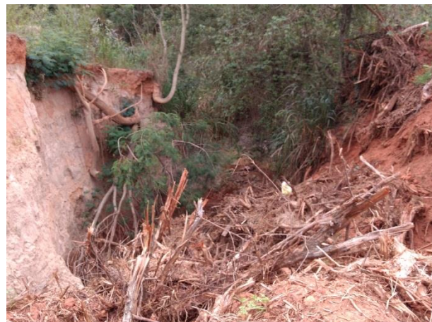
Foto 3.30 – Estrada rural a 100 m da cidade
