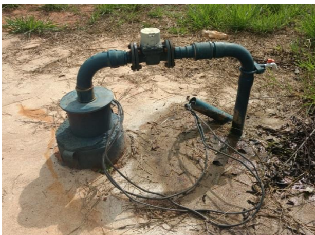
Foto 3.1 - Identificação do Poço: P4
