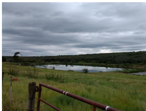
Foto 3.20 – ETE – Lagoa Facultativa
