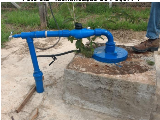
Foto 3.3 - Identificação do Poço: P3
