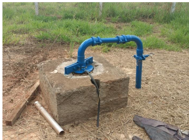
Foto 3.2 - Identificação do Poço: P2
