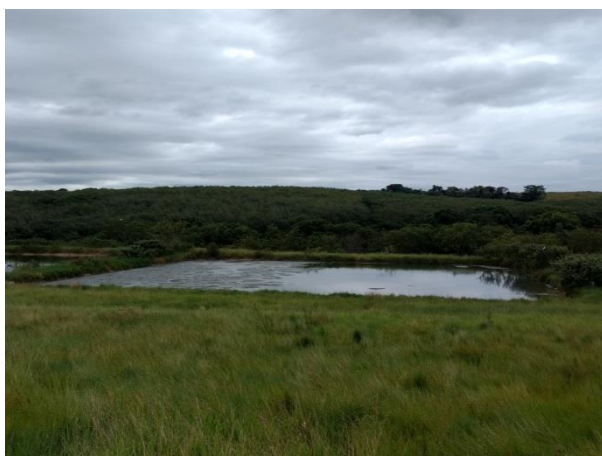
Foto 3.19 ETE – Lagoa Anaeróbia
