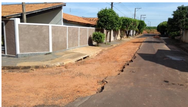
Foto 3.20 – Estruturas de microdrenagem
