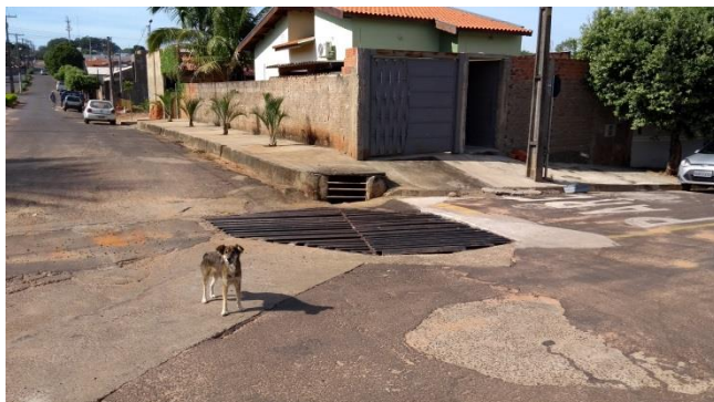
Foto 3.16 – Estruturas de microdrenagem
