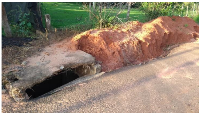
Foto 3.40 – Carreamento de materiais
