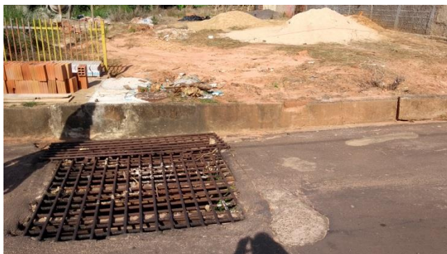
Foto 3.18 – Estruturas de microdrenagem
