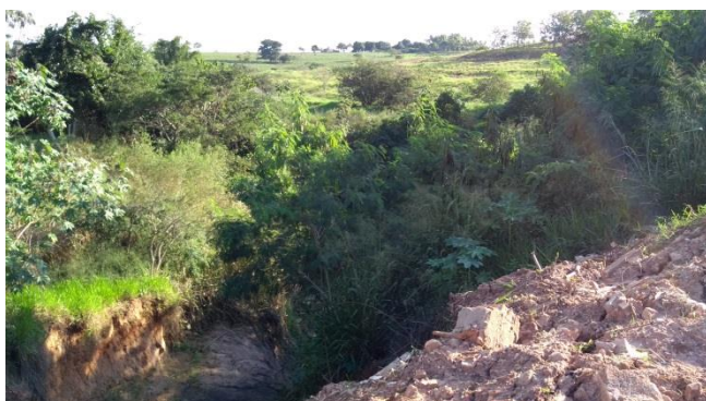
Foto 3.30 – Erosão ao lado da ETE
