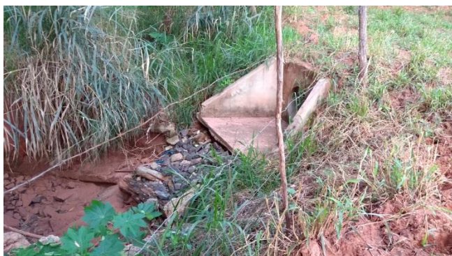
Foto 3.42 – Lançamento da galeria
