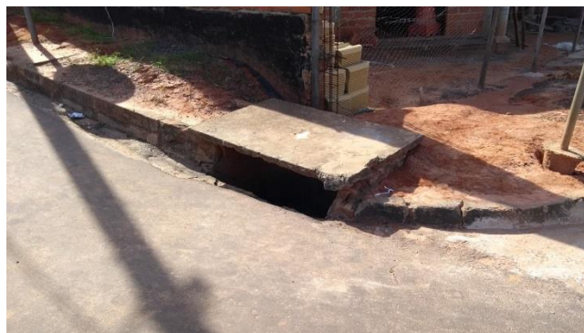
Foto 3.23 – Estruturas de microdrenagem
