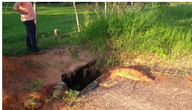
Foto 3.41 – Assoreamento da galeria
