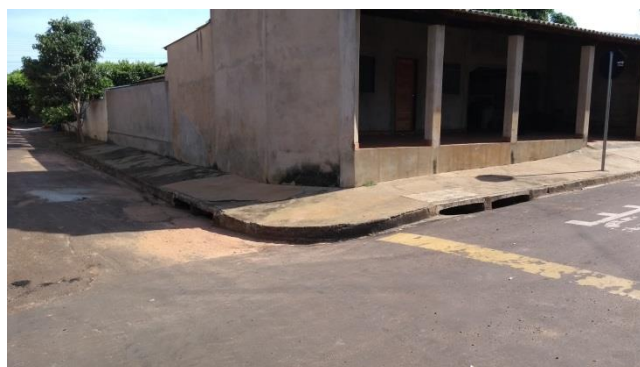
Foto 3.21 – Estruturas de microdrenagem
