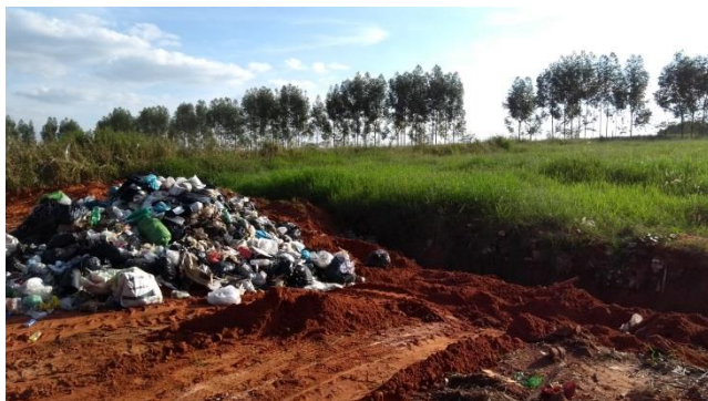
Foto 3.1 – Resíduos a serem compactados na vala
