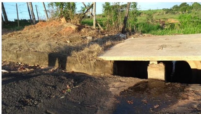
Foto 3.36 – Lançamento da GAP
