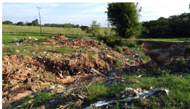
Foto 3.35 – Carreamento de materiais
