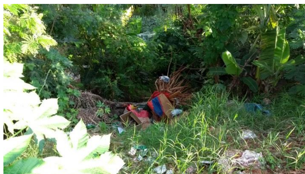
Foto 3.31 – Erosão ao lado da ETE
