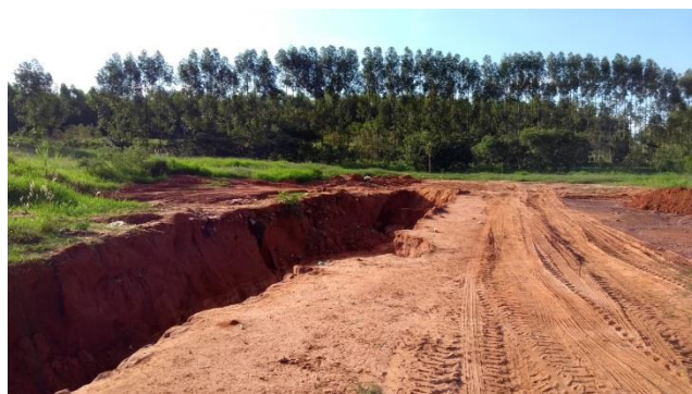
Foto 3.2 - Vista geral - Aterro
