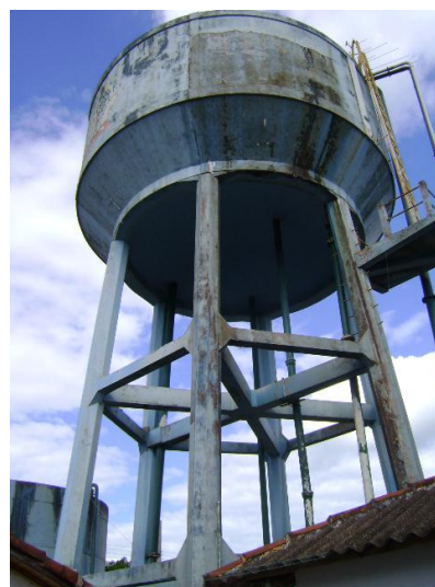
FOTO 4.6 – RESERVATÓRIO ELEVADO R1 CENTRAL
