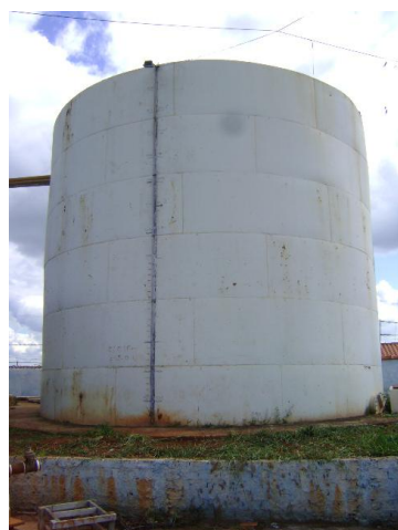
FOTO 4.9 – RESERVATÓRIO R2 DO BAIRRO JOÃO MARTINS
