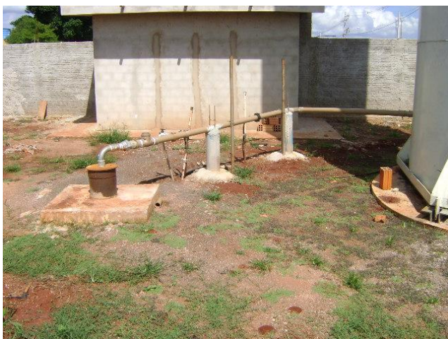
FOTO 4.21 – POÇO P12 QUE ABASTECE O SISTEMA JARDIM DOS BRILHANTES II
