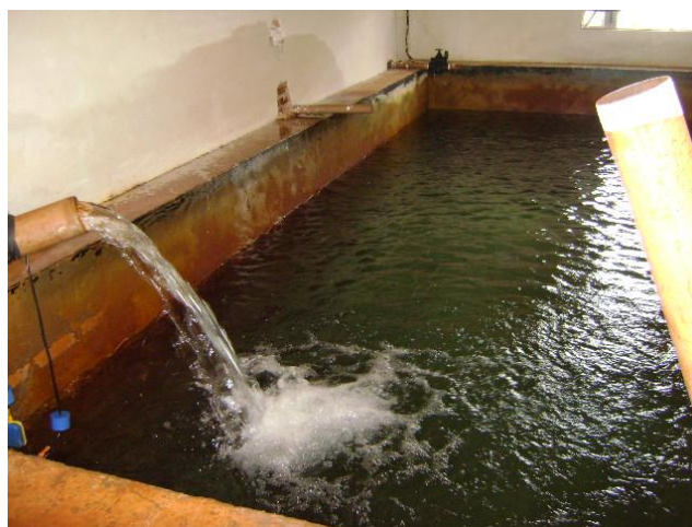
FOTO 4.19 – RESERVATÓRIO R2 DO SISTEMA ESTAÇÃO
