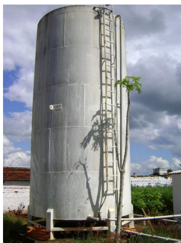
FOTO 4.18 – RESERVATÓRIO R1 DO SISTEMA ESTAÇÃO
