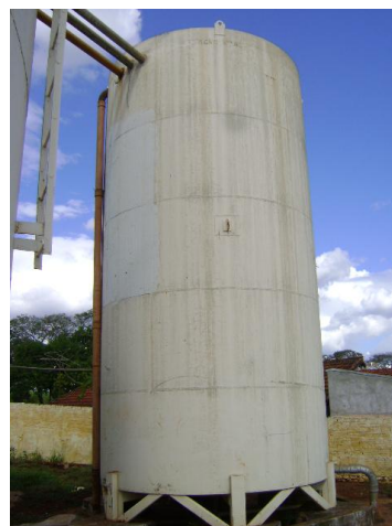
FOTO 4.8 – RESERVATÓRIO R1 DO BAIRRO JOÃO MARTINS
