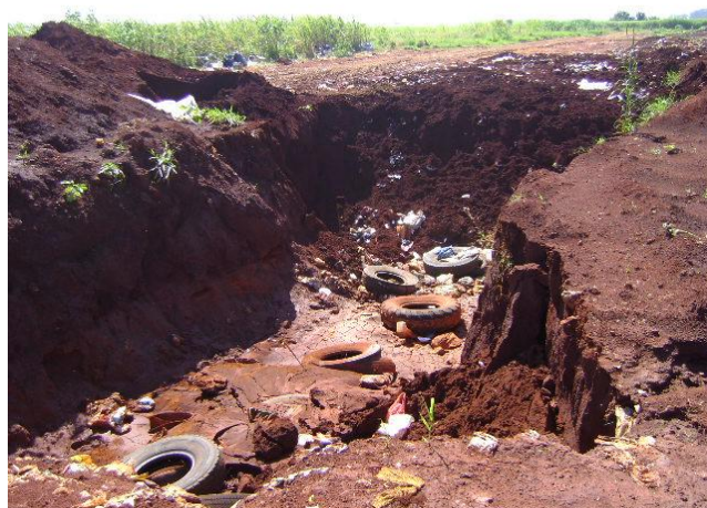
FOTO 4.31 – VALA DO ATERRO SANITÁRIO COM A PRESENÇA DE PNEUS E RESÍDUOS INERTES
