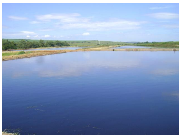
FOTO 4.28 – SISTEMA DA ETE IPAUSSU POR UMA LAGOA ANAERÓBIA (FRENTE) E UMA FACULTATIVA (FUNDO)
